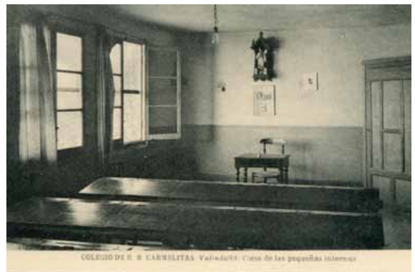
COLEGIO DE H. B. CAROLITAS Valladolid. Casa de las pequeñas internas
