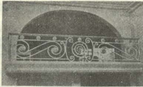
Mezzanine en el Hall principal. La reja de bronce en el balcón se identifica plenamente con el ambiente de nuestra casa.
