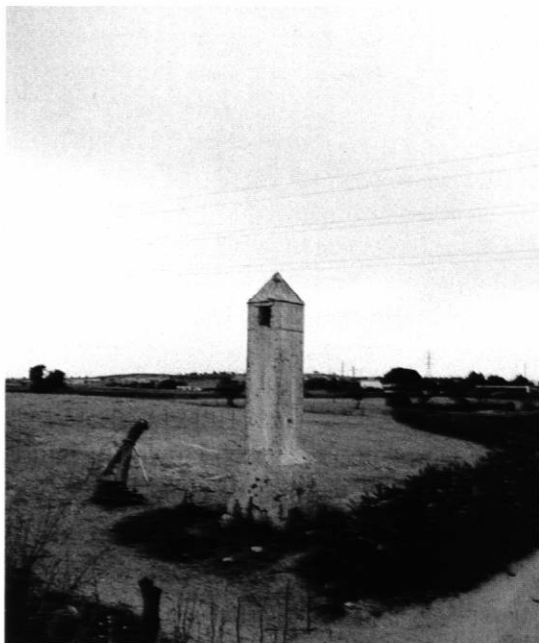
5.- Vista actual de los sifones de la noria de Villanueva.
