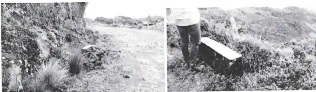
Fotografía No. 14 Alcantarillas
