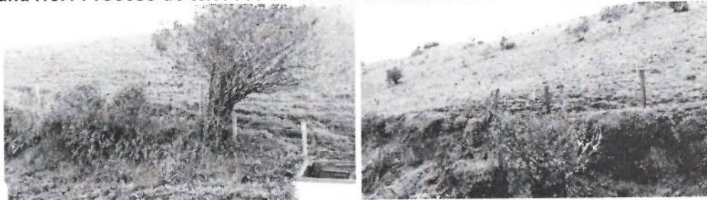
Fotografía No.4 Proceso de terraceo en el área de influencia directa de la Unidad Funcional 4
