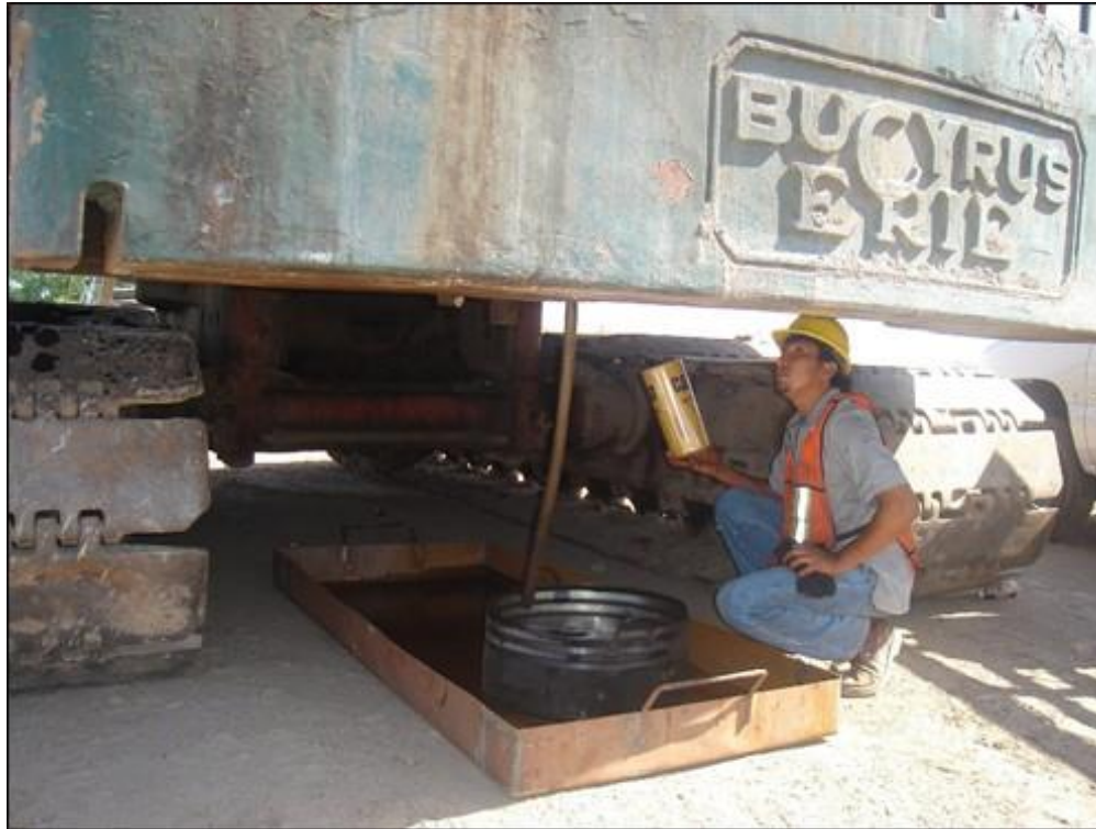
Figura 31. Ejemplo de la instalación de charolas para dar servicio de emergencia a la maquinaria.
