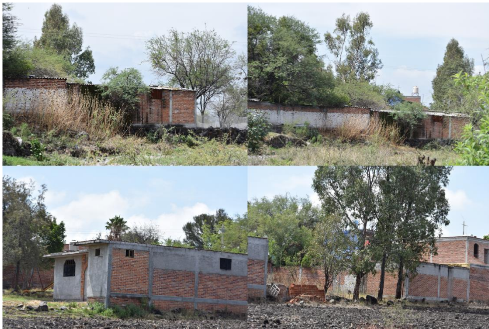
FIGURA 40. Viviendas localizadas en la comunidad La Lomita
