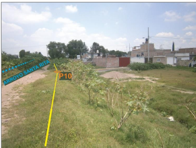
F12. Vista desde el pozo P09 hacia el pozo P10, se observa el trazo del proyecto y la presencia de algo de higuera, vegetación secundaria como pastos, gramíneas, maleza, hierba de época de lluvia a retirar por encontrarse dentro del trazo del proyecto; a la izquierda del trazo del proyecto se observa el Arroyo Santa Rita, sin afectar.
