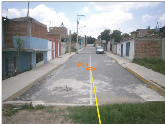
F09. Vista desde el pozo P06 hacia el pozo P14; en este trayecto se observa presencia de pastos y vegetación de época de lluvia a afectar.
