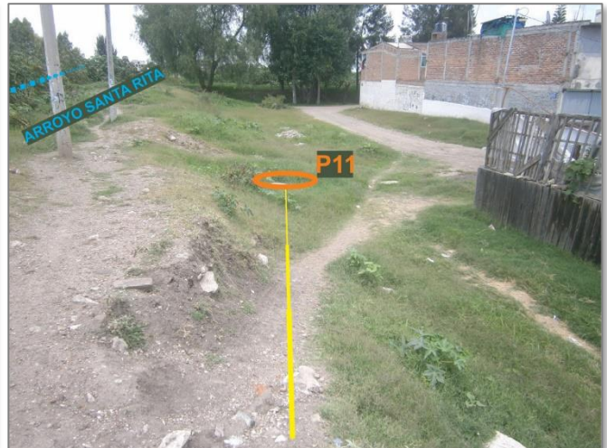
F14. Vista hacia el pozo P11, se observa el trazo del proyecto y la presencia de algo de higuera, vegetación secundaria como pastos, gramíneas, maleza, hierba de época de lluvia a retirar por encontrarse dentro del trazo del proyecto; a la izquierda del trazo del proyecto se observa el Arroyo Santa Rita, sin afectar.
