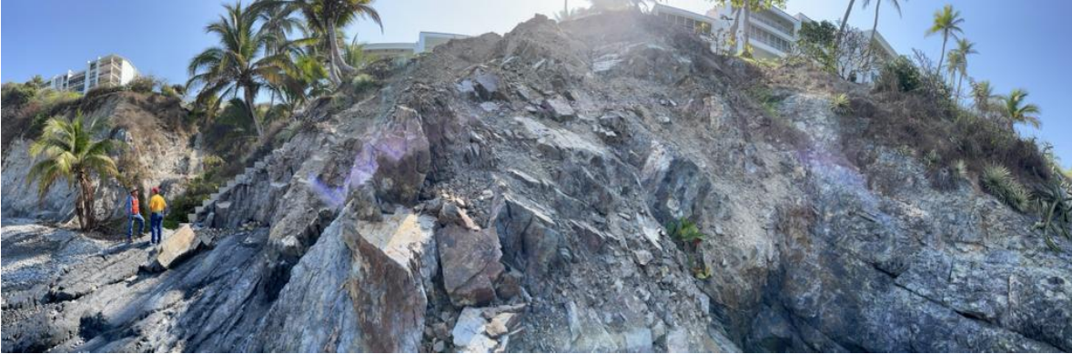
Ilustración No. IV.16 Imagen del sitio donde se ubicará el muro de contención, en la que se aprecia que no se tienen ejemplares de vegetación.
