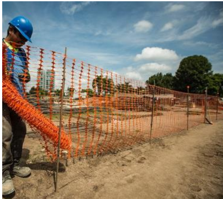
Ilustración No. II.11 Ejemplo de la instalación de malla delimitadora, con el fin de evitar la contaminación de residuos fuera del sitio del proyecto
