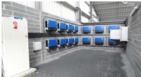
Figura II. 10.- Ejemplo de instalación de inversores distribuidos.
