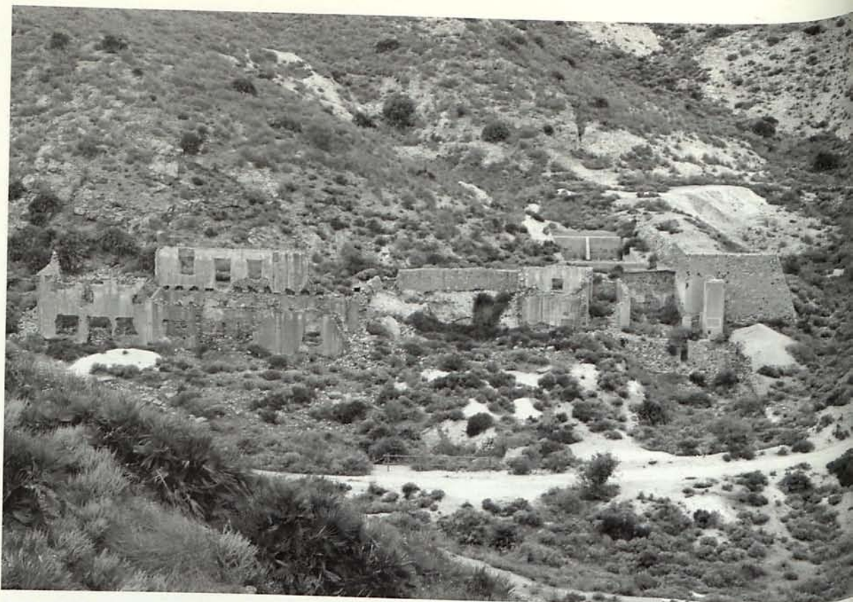
Figura 6. Edificio principal de la instalación metalúrgica propiedad de EMARSA. En la planta baja estaban los talleres, el almacén y la fundición, mientras que en la planta alta estaban las oficinas y los dormitorios.
