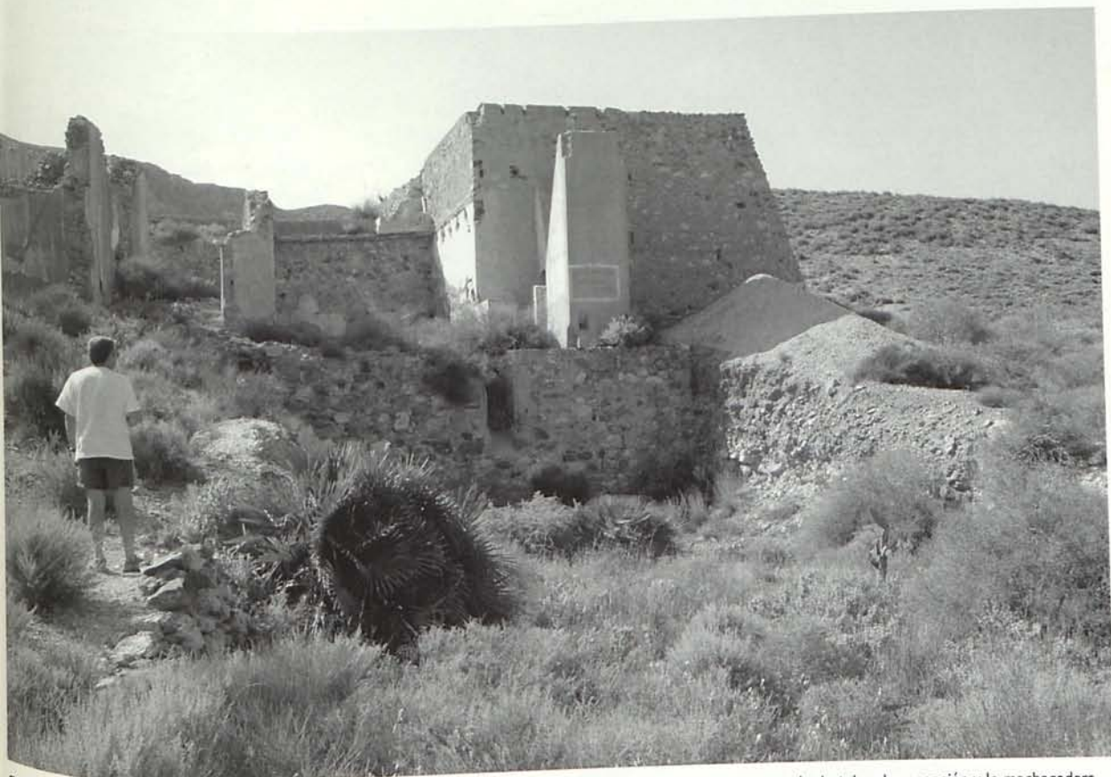
Figura 5. Área en donde se emplazaba la maquinaria de la instalación metalúrgica. En la zona más alta se encontraba la tolva de recepción y la machacadora. A continuación se emplazaba la batería de bocartes y el molino de bolas y finalmente el resto de la maquinaria metalúrgica se encontraba en el gran hueco situado a la derecha de la persona de la imagen.
