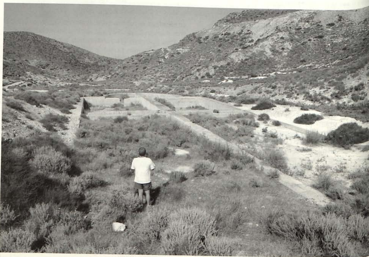
Figura 7. Estado actual de las 6 balsas del sistema hidráulico, dedicadas posiblemente al reciclado del agua utilizada en el proceso metalúrgico. Este era un apartado fundamental debido a la escasez del agua en la zona.
