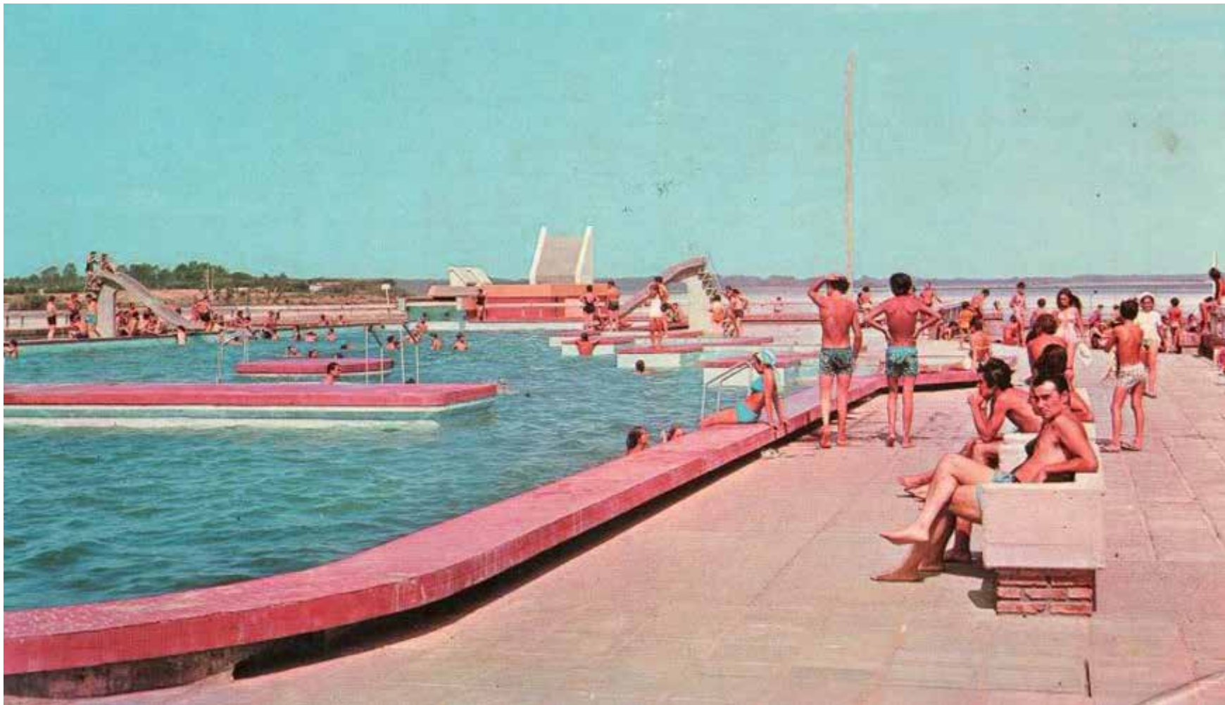
Epecuén 1980. Esperando la inundación. Imagen intervenida.
