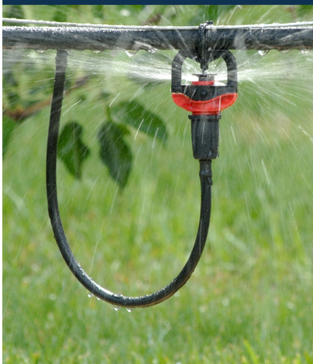
Instalación con base aspersor en espaldera
