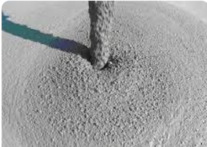
Requerimientos del concreto en estado fresco
