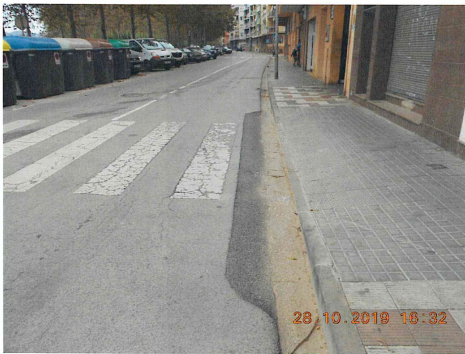
Foto nº 3. Av. Catalunya. Tram del traçat.
