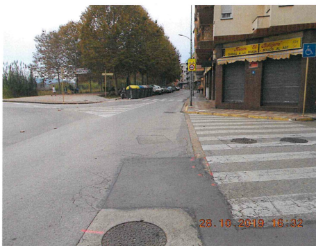
Foto nº 1. Av. Catalunya. Punt de confluència i connexió amb xarxa existent i C. Pau Neruda.
