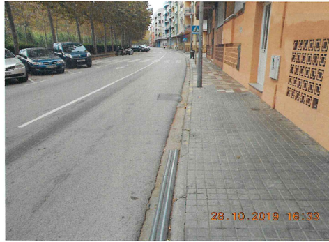
Foto nº 4. Av. Catalunya. Tram del traçat.
