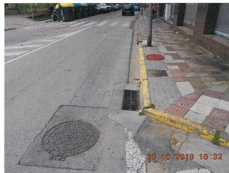
Foto nº 2. Av. Catalunya. Tram del traçat.
