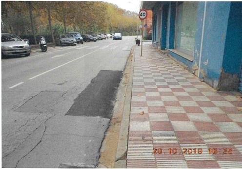
Foto nº 11. Av. Catalunya. Tram del traçat.
