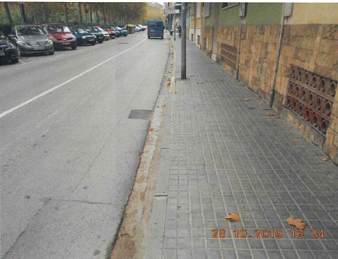
Foto nº 7. Av. Catalunya. Tram del traçat.
