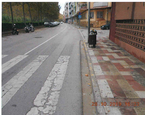
Foto nº 5. Av. Catalunya. Tram del traçat.
