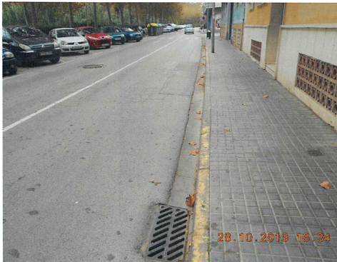
Foto nº 8. Av. Catalunya. Tram del traçat.
