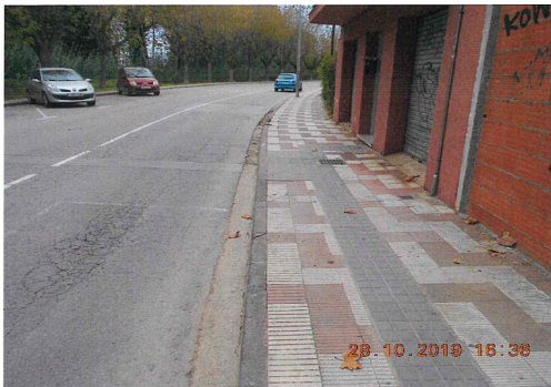
Foto nº 13. Av. Catalunya. Tram del traçat.
