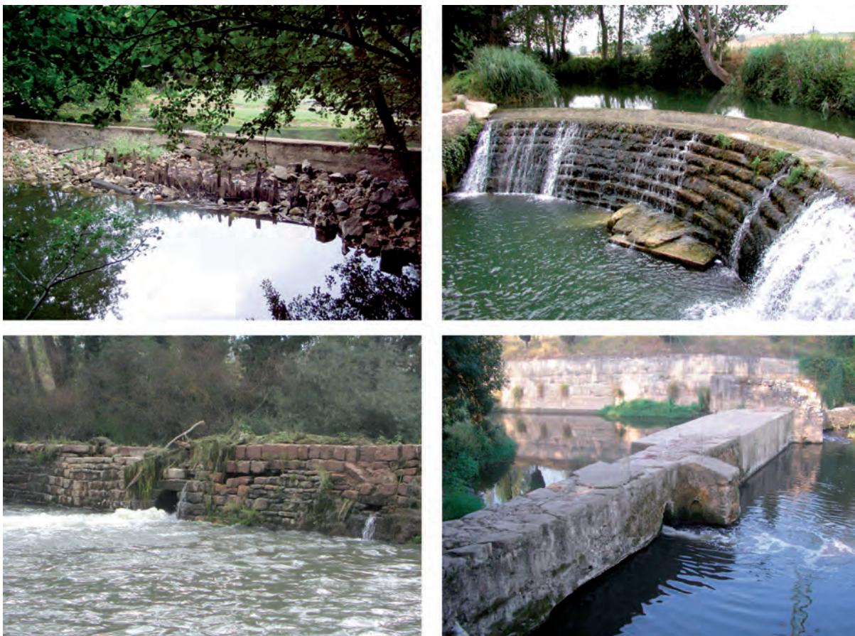
Figura 231; Arriba a la izquierda, presa de la ferrería privada y molino concejil de Abornikano (Urkabustaitz). Aguas arriba, con el caudal del río bajo, todavía se aprecian restos de la antigua estructura en madera. A su lado el espectacular ejemplar de El Prado (Berantevilla), una potente estructura con planta en arco y sección escalonada. En la fila inferior, a la izquierda, presa recta del molino de Axpea (Trespuestas, Nanclares de Oca). Se pueden ver perfectamente las distintas fábricas de piedra en sillería, sillarejo y mampostería, correspondientes a distintos periodos de uso y reparaciones de una estructura medieval que fue en origen propiedad de la familia Iruña para acabar siendo una pequeña central hidroeléctrica en el siglo XX. En último término, presa en Llodio, con un contrafuerte a medio lienzo que sostiene el paredón. Fuente: elaboración propia.
