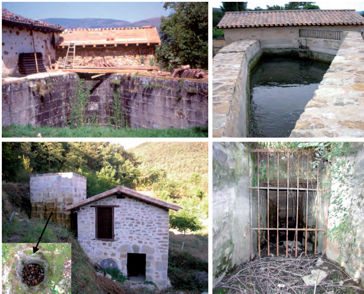
Figura 233; En la esquina superior izquierda, cubo de sillería del molino de Iduia en Araia (Asparrena). Junto a él, modesto depósito del molino de Arriba en Villanañe (Valdegovía). En la fila inferior, molino de Nograro en Valdegovía; junto al edificio se construyó a mediados del siglo XIX un cubo-torre que no sirve para almacenar gran cantidad de agua, sino más bien para conseguir una columna de gran altura que impulsa el líquido hacia los rodetes a gran velocidad. Finalmente, pecho del cubo y comienzo del saetín hacia los rodetes en la industria de Villodas (Nanclares de la Oca), protegido por reja de hierro para evitar atascos. Fuente; elaboración propia y Victorino Palacios Mendoza.
