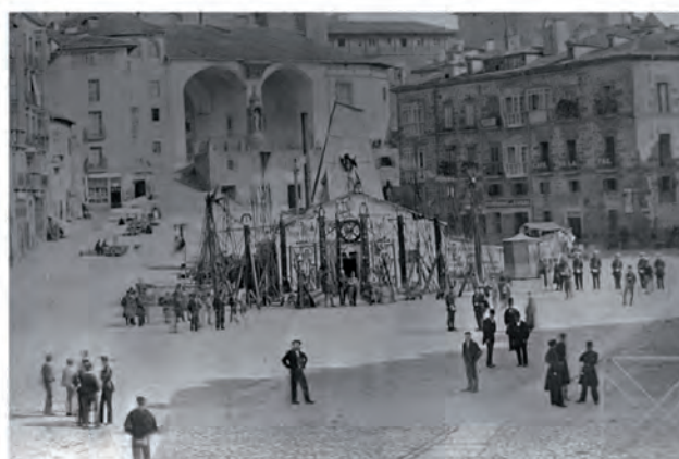
Figura 52; En la parte superior presentamos un esquema donde se recogen los distintos tipos de pozos y surgencias que hemos diferenciado según la estructura geológica que los contiene. Abajo a la derecha, fotografía que muestra la construcción de un pozo artesiano en la plaza de la Virgen Blanca de Vitoria el 22 de noviembre de 1877. Bajo la dirección del ingeniero francés Alphonse Richard y con la inversión del industrial vitoriano residente en Burdeos José González de Lopidana, el pozo llegó a alcanzar los 1.021 metros, siendo el más profundo de Europa por entonces, pero se abandona en 1882 sin haber hallado un venero de agua 279 . Lo que generó fue una enorme expectación en todo el continente e incluso Alfonso XII visitó las obras en octubre de 1878. A la izquierda, sección de un pozo tradicional (calle Diputación, 18, Vitoria-Gasteiz, intervención arqueológica) que capta agua del nivel freático (capa libre). Es importante destacar que no presenta argamasa o revestimiento entre la mampostería y que el fondo es hueco, con objeto de facilitar la filtración de las aguas. Fuentes: elaboración propia a partir de George, P. (dir.), Diccionario Akal de Geografía , Madrid, (1970) 2007, p. 89; Archivo Municipal de Vitoria-Gasteiz; fotografía de Paquita Sáenz de Urturi Rodríguez, directora de la intervención arqueológica.
