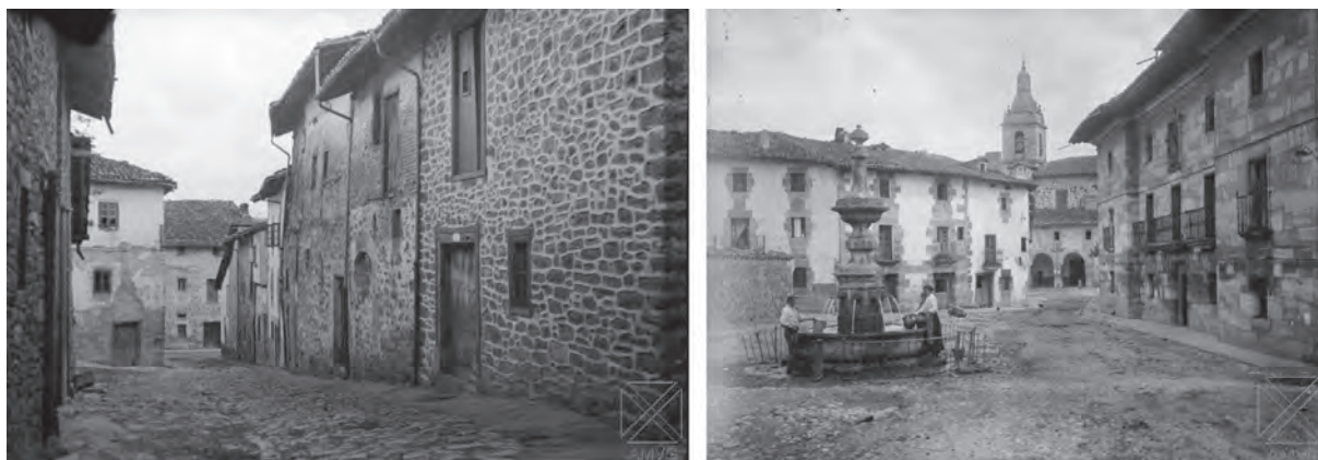
Figura 143; A la izquierda calle de Alegría en 1940, con el clásico encachado, el cordón central levemente rehundido para el discurrir de las aguas y las aceras enlosadas. A la derecha fuente de Maestu a principios del siglo XX, con la plaza sin empedrar, únicamente el entorno inmediato a la fuente, algo muy habitual incluso en los núcleos de mayor entidad. Fuente: Archivo Fotográfico Guinea (GUI I-226.2 y GUI IV-012.05), Archivo Municipal de Vitoria-Gasteiz.
