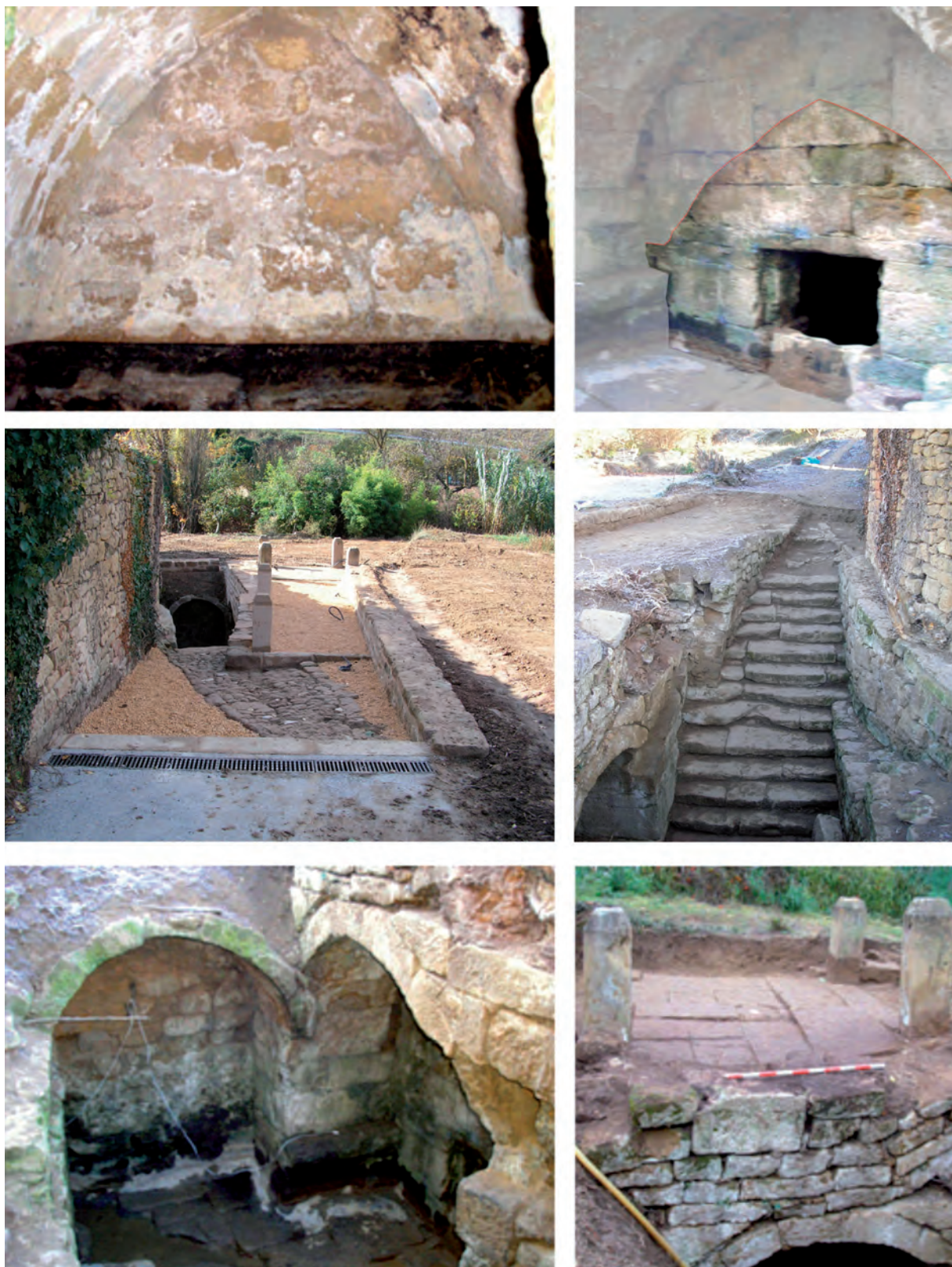
Figura 88; Sucesivas fases constructivas de la fuente vieja de Navaridas. En la fila superior el depósito original con bóveda apuntada, adscribible cronológicamente a partir del material hallado en la intervención arqueológica a la primera mitad del siglo XVI o incluso algo antes. En la fila intermedia se refleja el momento de mayor esplendor del conjunto, a mediados del siglo XVII: la construcción primitiva se esconde tras un nuevo arco decorativo de acceso al agua, construyéndose una plazuela empedrada, bancos de espera y un acceso escalonado. También datan de este momento los restos de empedrado viario hallados, correspondientes al camino de descenso desde la nueva villa. En torno a 1750 (abajo a la izquierda) el elemento está ya bastante deteriorado, y debido a un reordenamiento del espacio hortícola se debe reforzar la entrada a la fuente, perdiéndose la plazuela inmediata a la fuente, parte del acceso escalonado y creándose un túnel cubierto de seguridad, que rompe literalmente el frente de sillería creado a mediados del siglo XVII. Finalmente, las condiciones de servicio son tan precarias que se idea a principios del siglo XX un nuevo camino que lleva a una plataforma sobre el manantial (exactamente sobre el depósito abovedado más antiguo) y allí se instala una bomba (esquina inferior derecha), perdiéndose definitivamente la identidad histórica del elemento.
