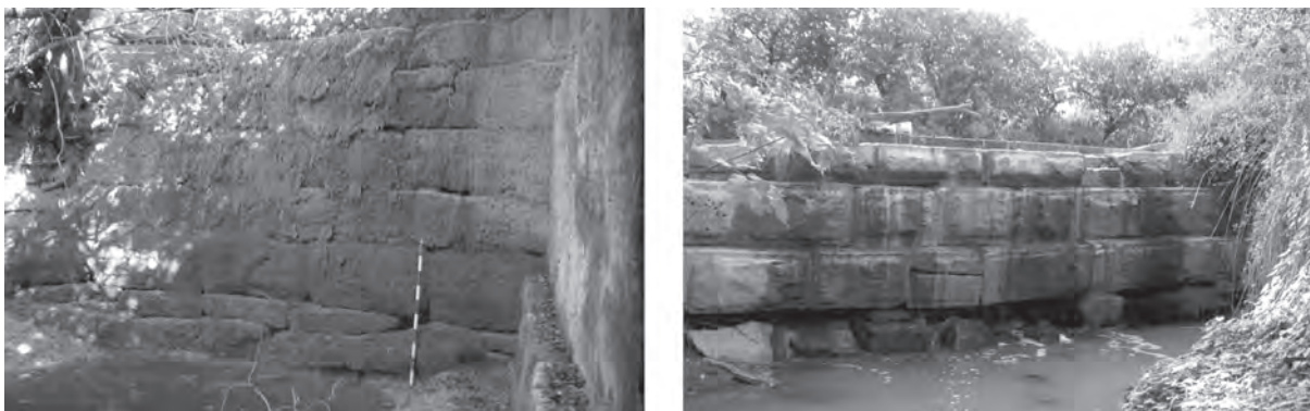
Figura 181; Presas de Pasadillamala en Oyón y del Arca (regadío Linares) en Baños de Ebro, ambas en Rioja Alavesa. La primera data de 1697 y la segunda es una obra posterior a la que mencionamos a continuación de 1598. Fuente: fotografías de Victorino Palacios Mendoza.
