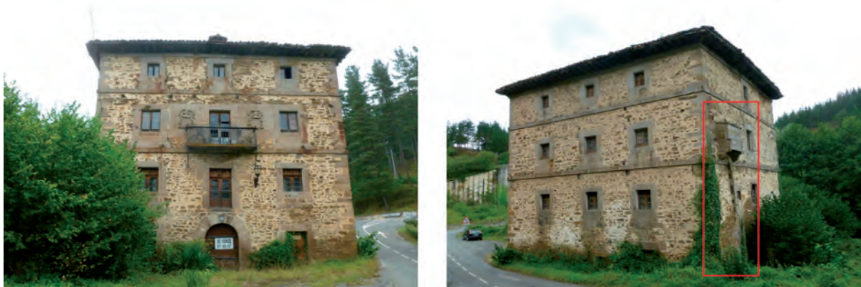
Figura 134; Palacio Jauregia en Berganza (Baranbio), la arquitectura culta rural de finales de la época moderna está dotada en la parte trasera de un “matacán” (así ha sido tomado por algunos historiadores e historiadores del arte) que en realidad se trata de una letrina pétrea en voladizo que ni formó parte de la estructura original ni funcionó en un principio con canalización hacia el subsuelo, siendo esta un añadido relativamente reciente. Fuente: elaboración propia.
