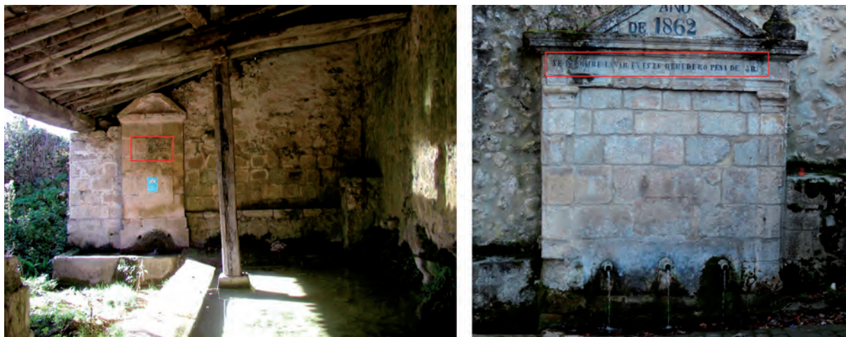
Figura 122; Fuente Vieja de Contrasta a la izquierda, que conserva inscrito el lema “De parte del Ayuntamiento no se permite lavar”, refiriéndose al área de servicio de agua de boca; para estos menesteres se acondiciona un pequeño lavadero adyacente. A la derecha, fuente de Bernedo en cuyo frente decorativo se puede leer “Se prohíbe lavar en este bebedero pena de 4r”. Fuente: elaboración propia; CON_001 y BER_002 respectivamente.
