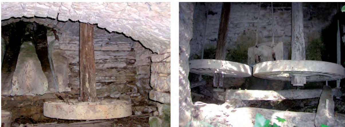
Figura 234; A la izquierda estolda del molino de Villamanca (Kuartango), que todavía conserva un saetín de tipo antiguo, abierto y con pesebre de madera. A la derecha, estolda del molino de Luna (Kuartango) que posee ya un saetín cerrado y terminado en cañón de hierro. Se puede ver perfectamente como los pesados rodetes se sostienen sobre un punto minúsculo de bronce, encastrado en el extremo inferior del árbol o eje vertical. Fuente: Victorino Palacios Mendoza.
