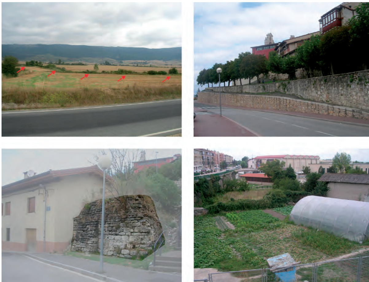
Figura 70; Restos conservados de la traída artificial. Tramo de la canalización serpenteando entre heredades de cereal; “barbacanas” de la villa por donde discurría el foso, hoy amortizado por un paseo bajo arbolado y una carretera que circunvala el núcleo; cubo o depósito previo del molino de San Juan (siglo XIX, código prospección SALV_007), ya arruinado; zona hortícola que todavía hoy día se asienta entre la antigua cava y el arroyo Santa Bárbara. Fuentes: elaboración propia.
