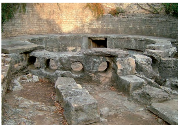
Figura 127; A la izquierda restos del castellum aquae de época romana de Nimes (Francia), donde se puede apreciar perfectamente la piscina circular y la distribución a través de distintas salidas. A su lado, recreación del circuito vitoriano a partir de un ejemplo real (arca de la traída soterrada de Berantevilla en Álava, del siglo XVIII) organizado verticalmente. La cañería entra en un depósito o arca subterráneo que está protegido por una imponente estructura maciza para que no se pueda manipular arbitrariamente. Allí, tres salidas distintas se superponen de forma que la más baja tiene asegurada la alimentación durante más tiempo. Por el contrario, si el caudal escasea y no llega a llenar el depósito, la salida superior queda sin abastecimiento. Fuente: elaboración propia.
