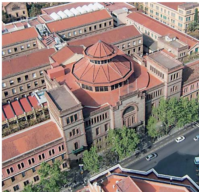
Figura 5. Aspecto exterior del Ilanternó del Paranimf en la actualidad, previo a las obras.
