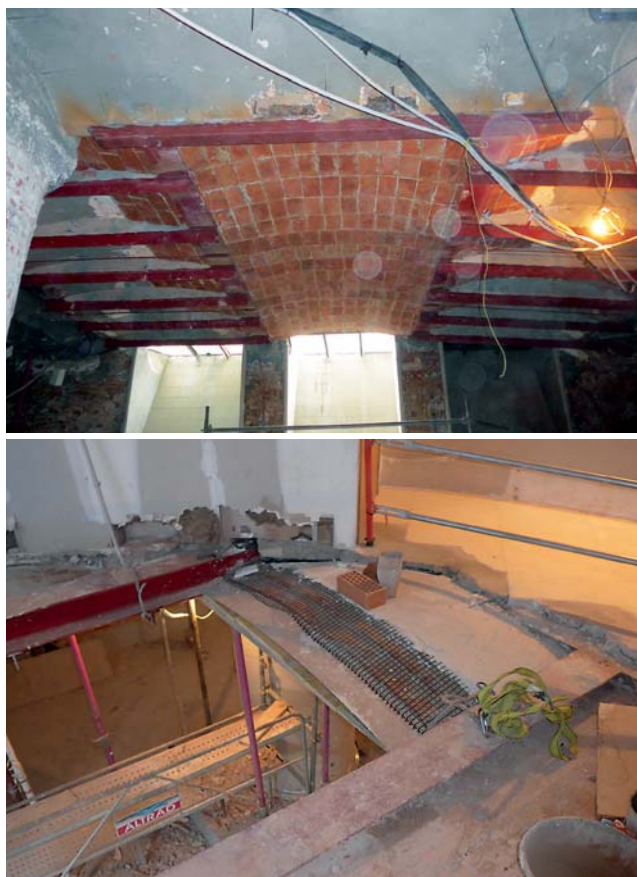
Figura 11. Fotografías de la bóveda del sótano.
