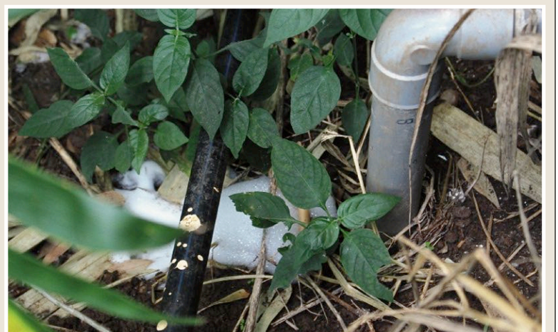
L'évacuation de la baignoire se fait au pied du mur de la salle de bains, et participe au décaissement de la terre qui soutient le sol de la chambre voisine...
