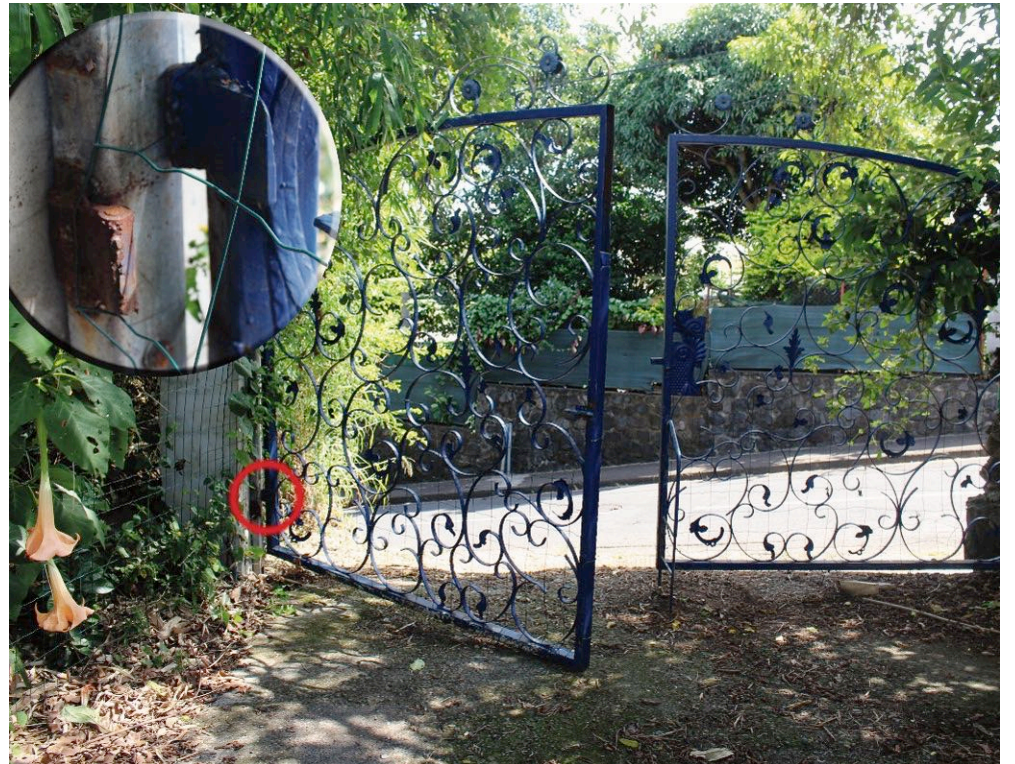
Le portail d'entrée n'a pas été épargné. Un des battants a failli écraser son utilisatrice lorsqu'un des gonds sommairement fixé a lâché.
