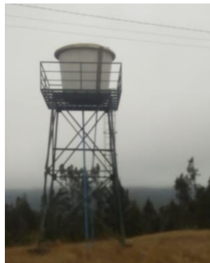
Instalación de estanques en sector de Reposo
