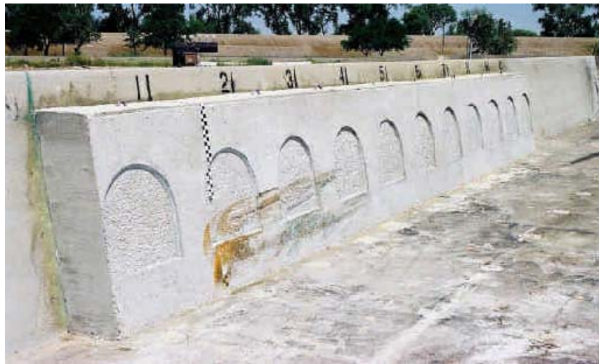
Fotografía 23 – Baranda de hormigón armado estética con bajo relieve
