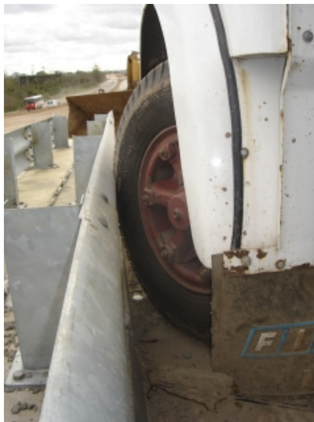
Fotografía 25 – Comparación de una baranda flex-beam h=0.60\text{m} con el rodado de un vehículo pesado (aproximadamente 1.10m de diámetro)
