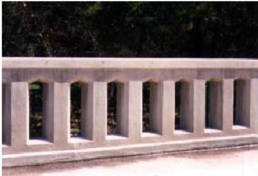
Fotografía 21 - Baranda vehicular y peatonal estética de hormigón armado
