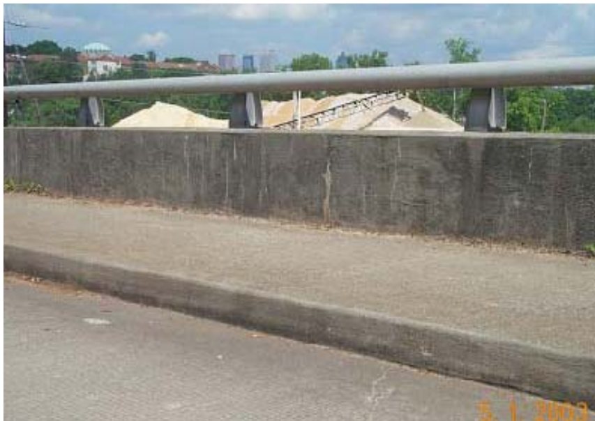
Fotografía 19 – Baranda vehicular y peatonal con paramento vertical de hormigón armado y pasamanos con caño galvanizado con cordón y vereda
