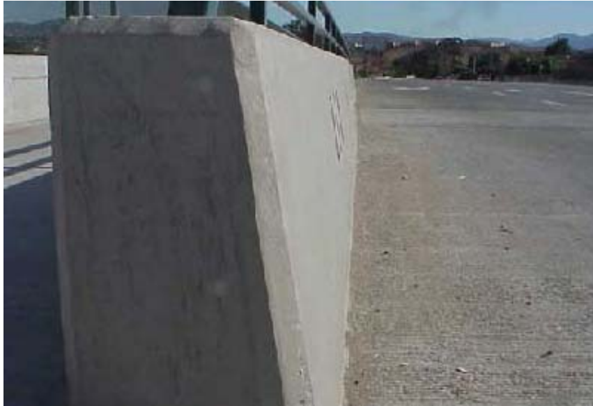
Fotografía 20 - Baranda vehicular y peatonal con paramento de una sola pendiente de hormigón armado y pasamanos de caños
