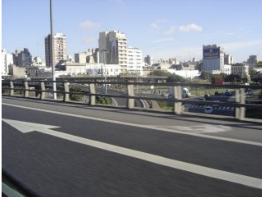
Fotografía 8 – Baranda vehicular y peatonal metálica de postes y caños sin guardarruedas
