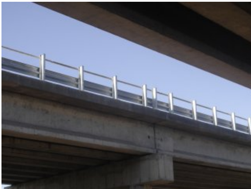
Fotografía 9 – Baranda vehicular y peatonal metálica tipo flex-beam con pasamanos de caños galvanizados
