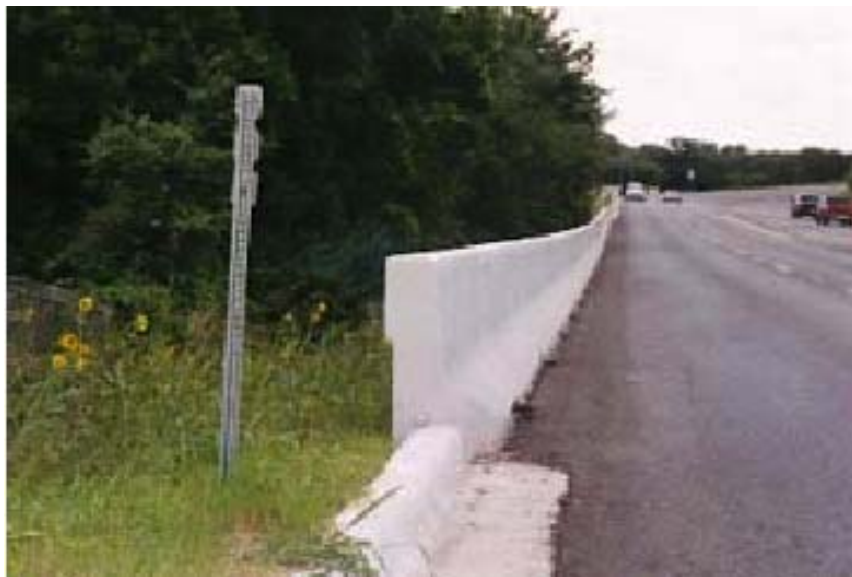
Fotografía 15 - Baranda vehicular de hormigón armado tipo F
