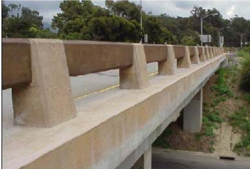
Fotografía 16 - Baranda vehicular abierta con postes y vigas de hormigón armado
