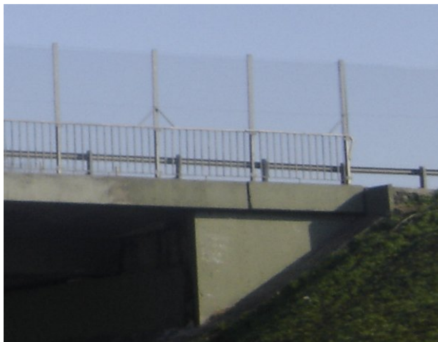
Fotografía 11 – Baranda peatonal vertical metálica, alambrado de protección, vereda y baranda vehicular metálica tipo flex-beam
