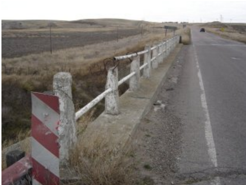
Fotografía 5 – Baranda vehicular y peatonal de postes de hormigón y caños galvanizados con guardarruedas
