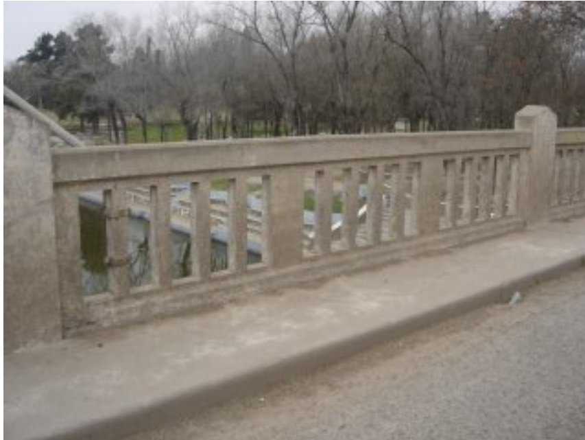
Fotografía 12 – Baranda vehicular y peatonal de hormigón armado, cordón y vereda de 1m
