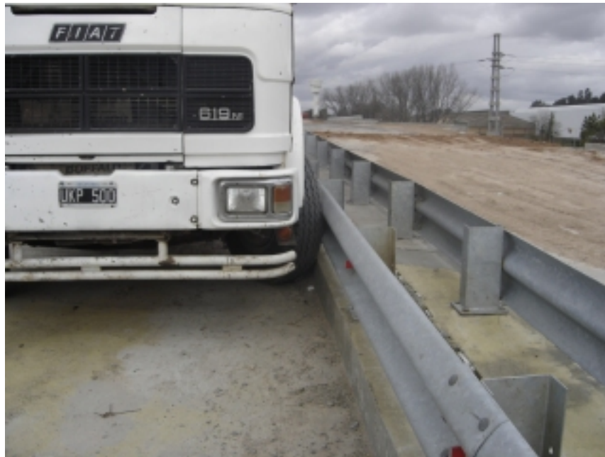
Fotografía 24 – Comparación de una baranda flex-beam h=0.60\text{m} con un vehículo pesado
