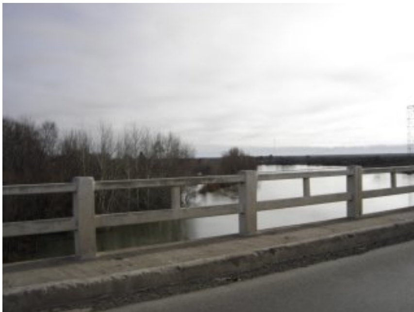
Fotografía 7 – Baranda vehicular y peatonal de hormigón armado
