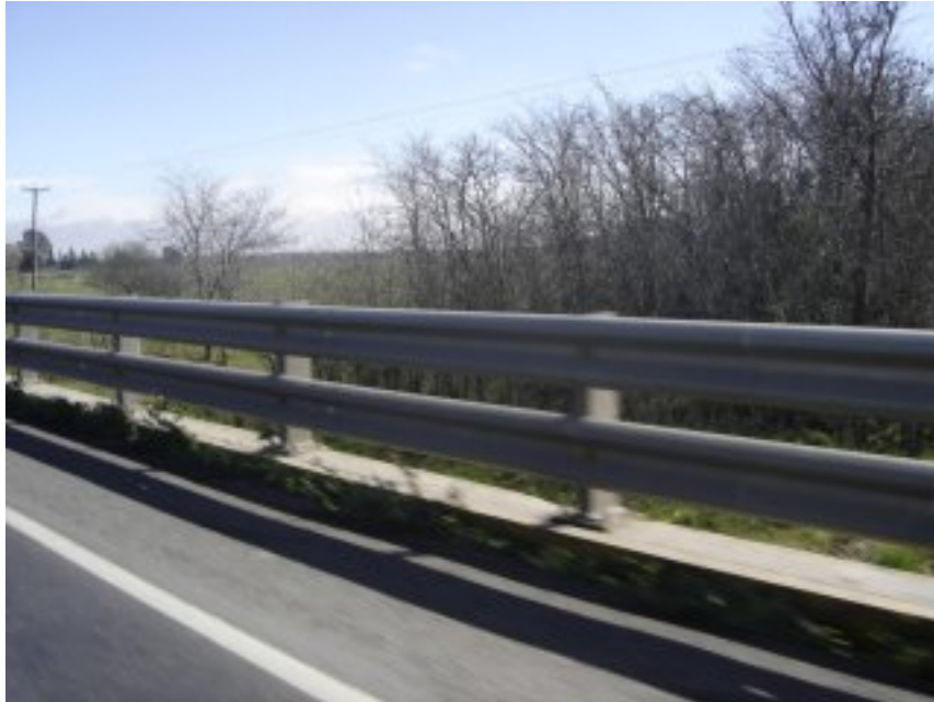
Fotografía 10 - Baranda vehicular y peatonal metálica tipo doble flex-beam con guardarruedas
