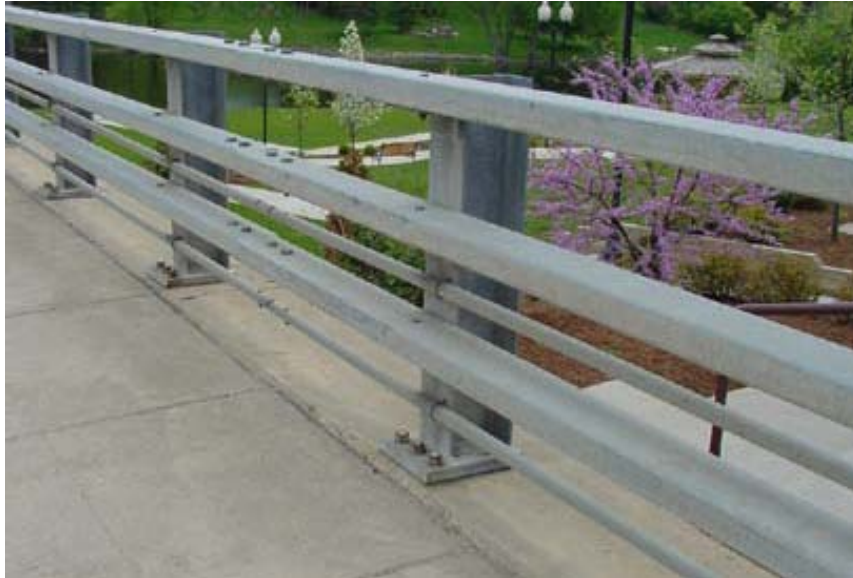
Fotografía 18 – Baranda vehicular metálica con postes y correderas de tubos
