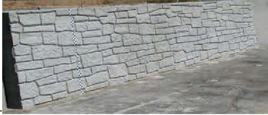
Fotografía 22 – Baranda de hormigón armado estética con revestimiento símil piedra
