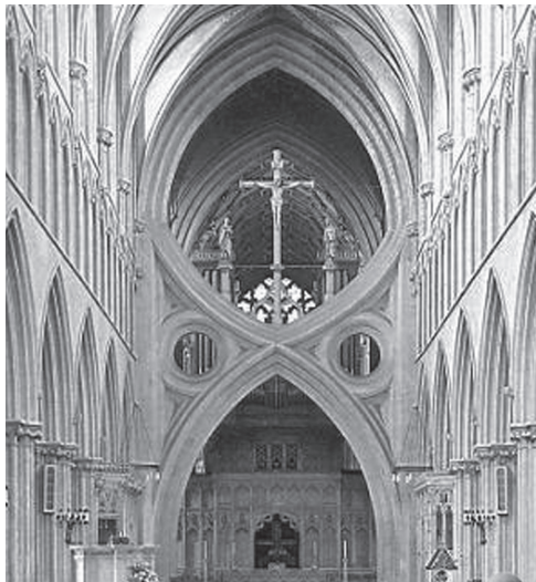
Figura 11 Figura izquierda: Arcos de tijera para refuerzo, necesarios por el peso de la torre sobre el crucero en la Catedral de Wells. Figura derecha: Arcos entibos colocados en la cabecera de la Iglesia de Nuestra Señora de la Asunción en Castro Urdiales. (Benito 2011)
