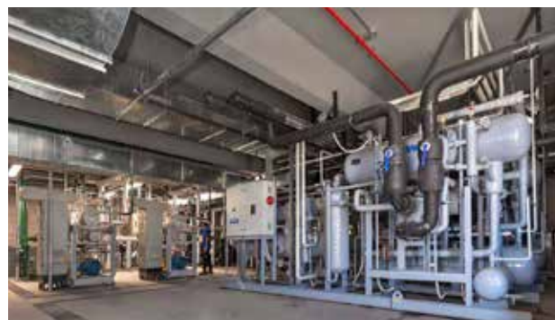
Enfriadoras de agua con gas amoníaco
