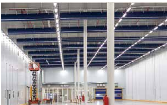
Vista general del depósito con los conductos textiles color azul
