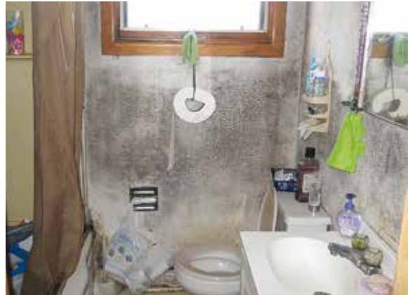
Foto 2. El mismo baño en Wisconsin. Observe la evidencia de las manos tocando la pared mohosa junto al inodoro.
