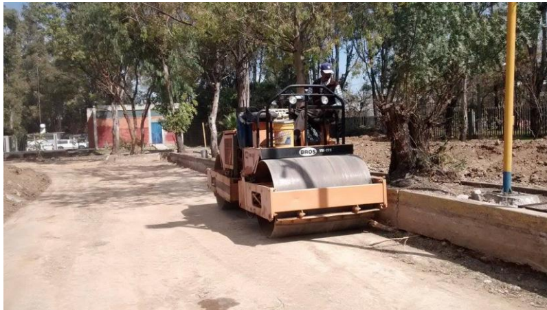
Imagen 12. Compactación por medio de rodillo metálico
