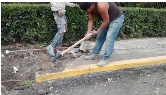
Imagen 26. Demolición de banquetas.
