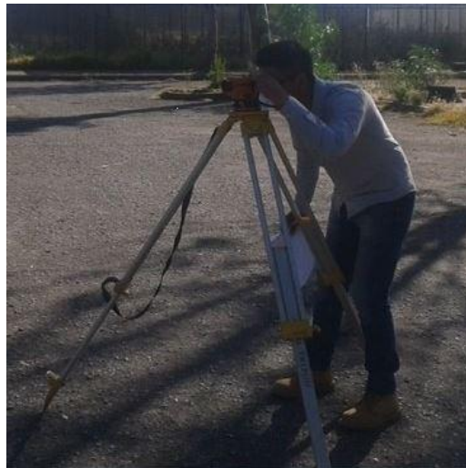
Imagen 3. Nivelación del estacionamiento
