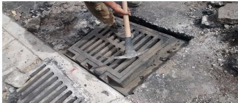
Imagen 23. Colocación de rejilla.
