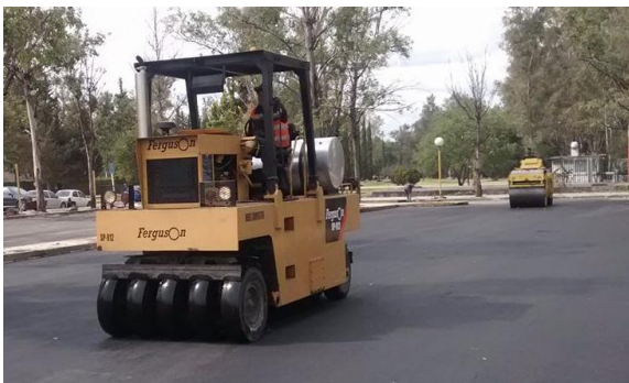
Imagen 19. Compactación de carpeta.
