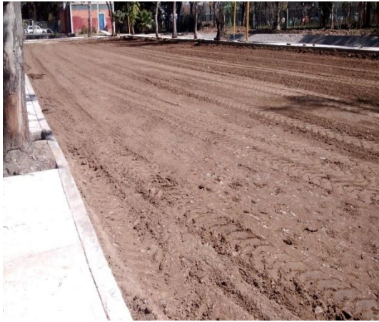
Imagen 14. Base sin compactar.
