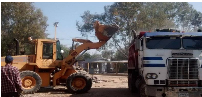
Imagen 25. Retiro de materiales producto de demolición.
