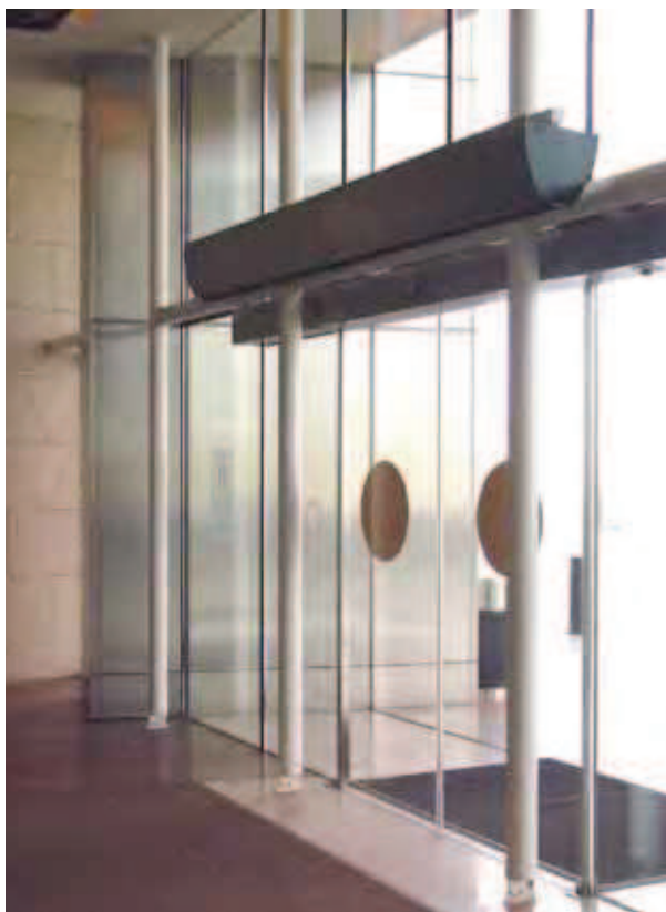
Dwa urządzenia można zamontować razem używając zestawu łączącego, tworząc ciągłą kurtynę powietrzną nad szerokim przejściem.
