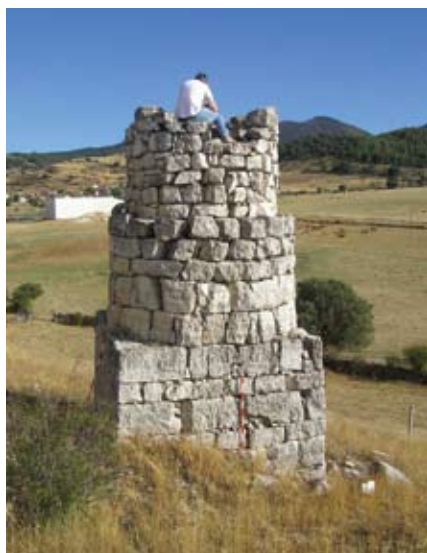
Figura 19. Trabajando en lo alto de la chimenea, vista del lado occidental.
