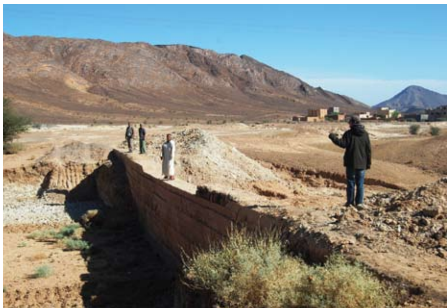
Figura 8. Presa de cemento en un oued.
