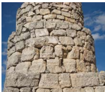
Figura 20. Detalle de la gran plasticidad del sillarejo calizo empleado en los tres cuerpos de la chimenea de la Fuente de las Viñas.
