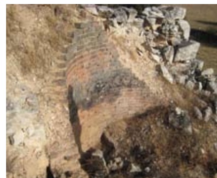
Figura 7. Detalle de la cámara de ladrillo del horno industrial oriental, arruinada en su mayor parte, donde se coció de forma infructuosa cal, ladrillo y teja.
