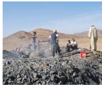
Figura 6. Excavación de una khettara de montaña.
