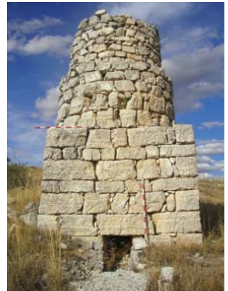
Figura 18. La chimenea de tres cuerpos de buen sillarejo, en su lado meridional, con la entrada del canal de tiro en la parte inferior.
