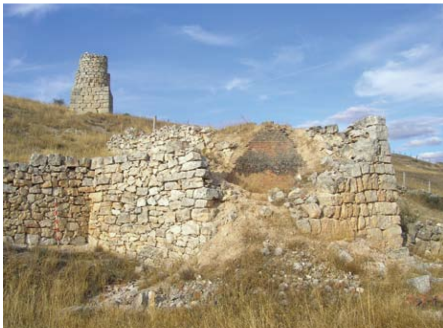
Figura 6. El horno industrial oriental con cámara de ladrillo, cuya envoltura exterior de buen sillarejo presenta ruina parcial que permite ver su interior. Al fondo la chimenea con la que se conectaba.
