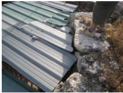
Figura 16. Detalle del muro de sillarejo calizo que envolvía en forma curva la cámara del horno industrial mayor, situado al oeste del complejo. Hoy se utiliza como perrera.
