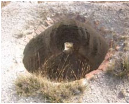
Figura 15. Vista de la parte superior de la caldera del horno tradicional occidental.
