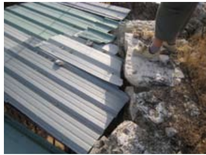
Figura 16. Detalle del muro de sillarejo calizo que envolvía en forma curva la cámara del horno industrial mayor, situado al oeste del complejo. Hoy se utiliza como perrera.
