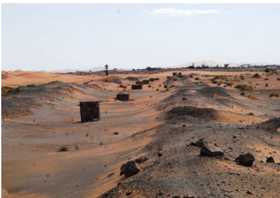
Figura 5. Khettara con cada reggar elevado para prevenir inundaciones.
