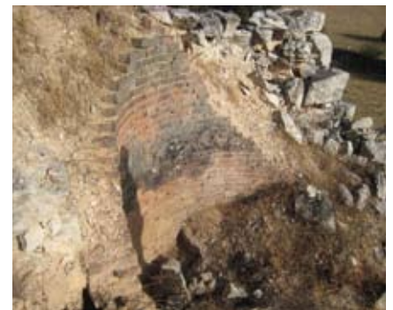
Figura 7. Detalle de la cámara de ladrillo del horno industrial oriental, arruinada en su mayor parte, donde se coció de forma infructuosa cal, ladrillo y teja.
