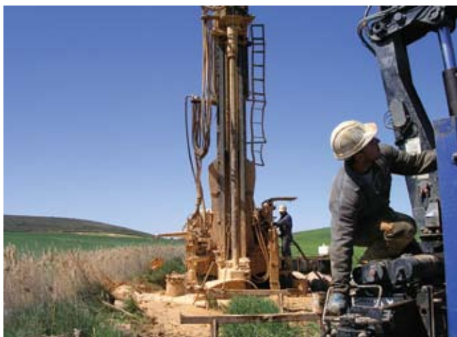
Figura 3.1. Perforación de un sondeo de investigación hidrogeológica en materiales detríticos terciarios en Montalbo.
