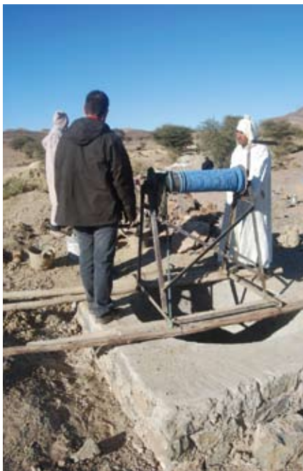
Figura 4. Vista de una chimenea de una khettara en construcción realizada por CERAI.
