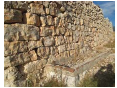
Figura 10. Una de las piletas para barro construidas al exterior del muro perimetral del complejo industrial.
