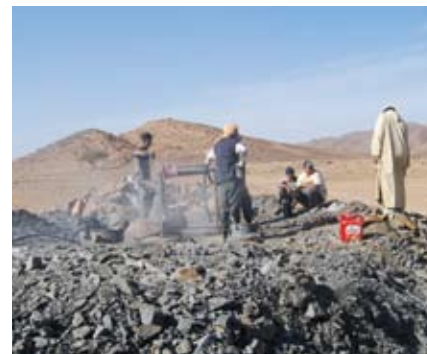
Figura 6. Excavación de una khettara de montaña.
