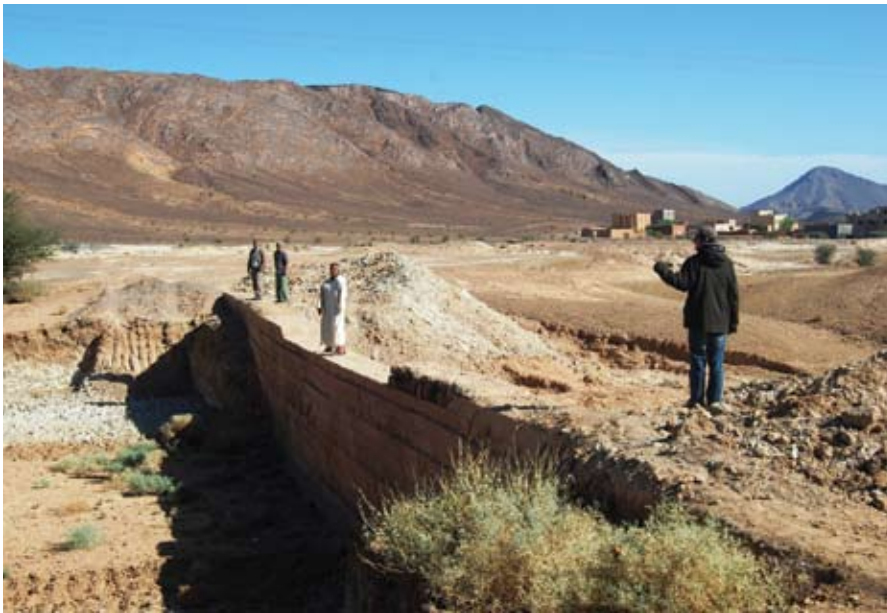
Figura 8. Presa de cemento en un oued.
