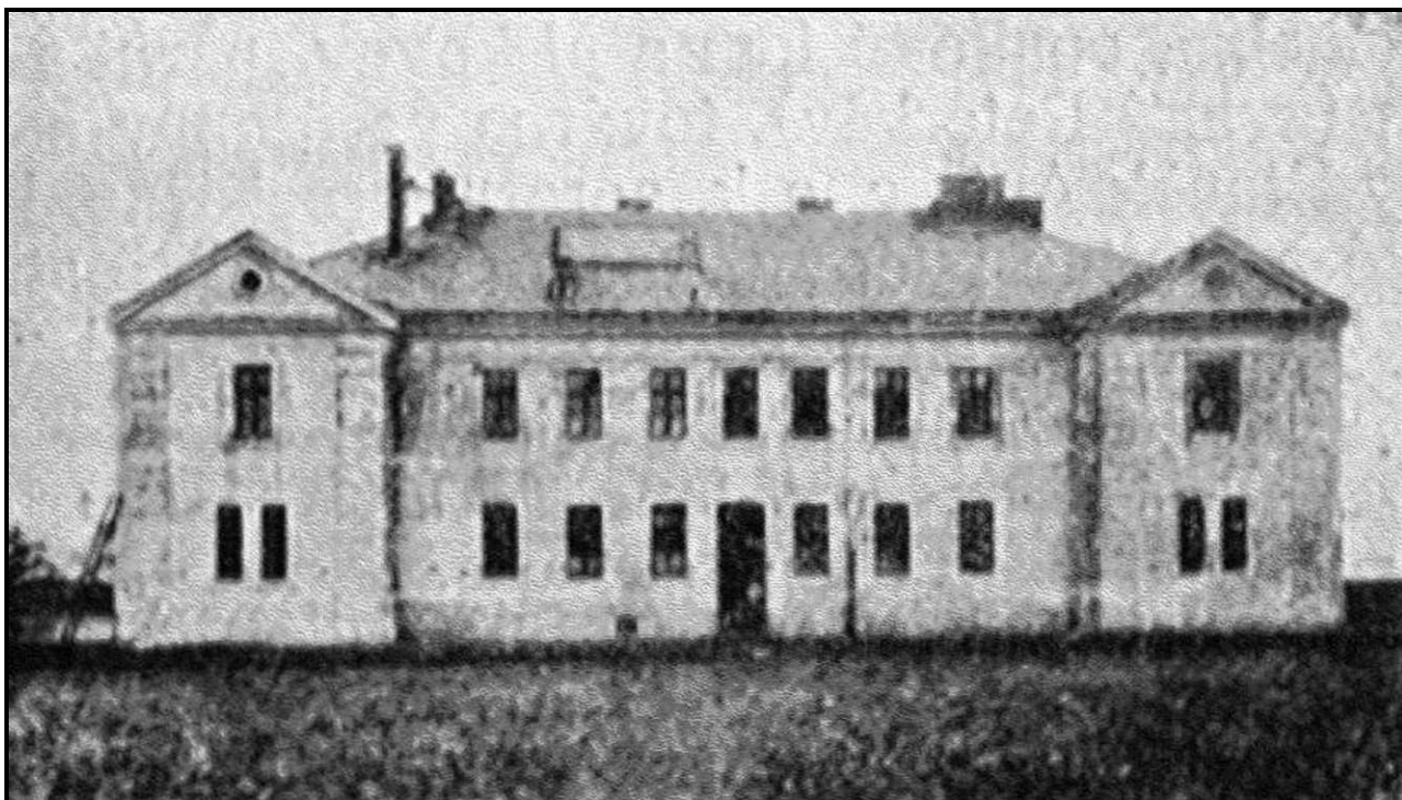
Kasárna nová pro střídající se vojenskou stráž u pracháren.
