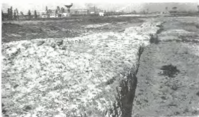
Il molo che fu costruito dall'Imperatore Claudio riportato alla luce nella sua interezza.
