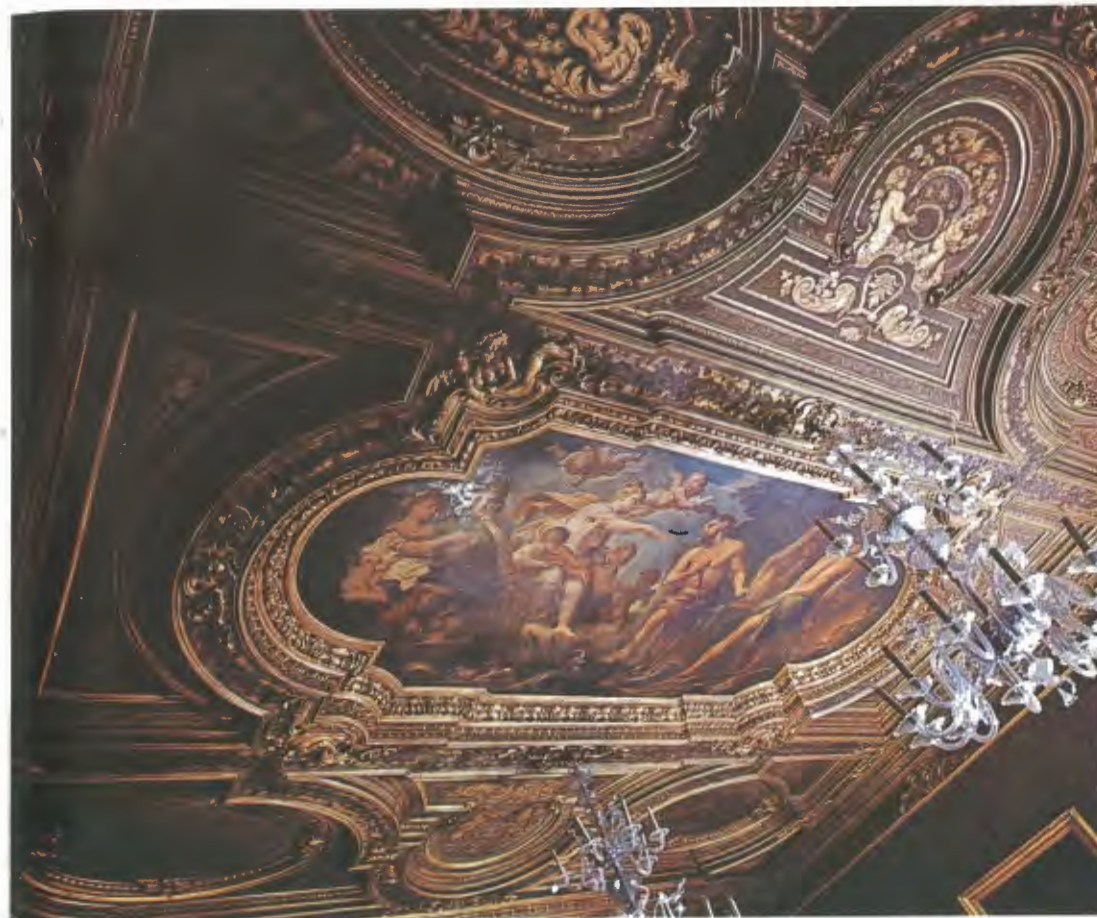
Particolare del soffitto.
