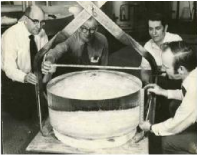
Detector NaI de 81cm de diámetro construido por Harshaw
