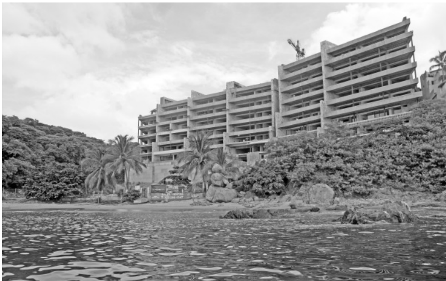
Fotografía 16. Arena blanca. Obra en proceso que ya anuncia la venta de espacios.
