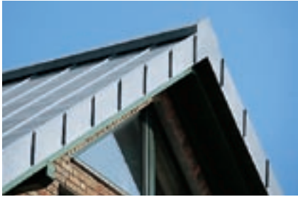
Cumbrera de cubierta a dos aguas, versión alta, con secciones transversales para la salida de aire
