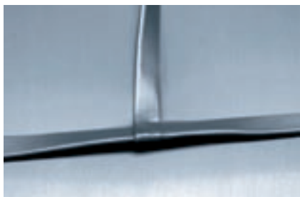
Nudo (4) Bandeja en junta transversal, zona posterior
