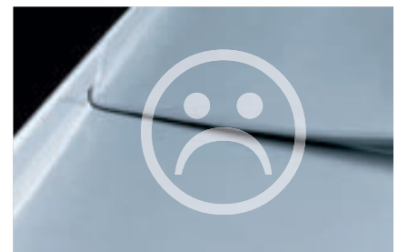
Cubierta a un agua sin espacio para dilataciones y altura de remate demasiado baja
