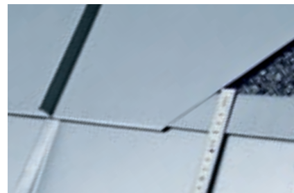
Junta transversal engatillada sencilla
