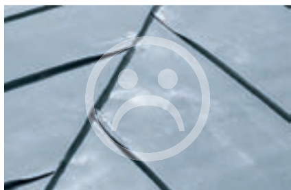
Limatesa o cumbre como junta alzada doble
