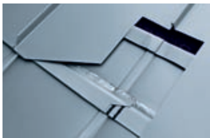
Optimización: Tira de sujeción adicional
