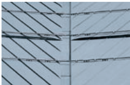
Limahoya encastrada sobre malla estructurada
