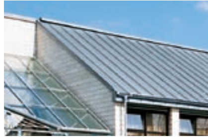
Cumbrera de cubierta a un agua con listón de madera
