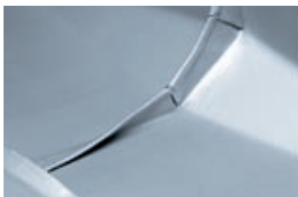
Pliegue de cabeza doble en la junta transversal (3) Zona posterior
