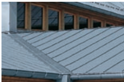
Limahoya con engatillado sencillo y pestaña adicional
