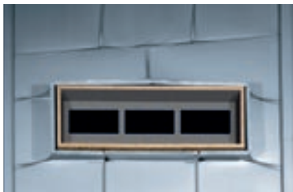
Estructura pasante de cubierta Detalles: Ejecución correcta en técnica de engatillado (ver dibujo pág. 12)
