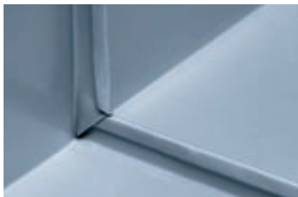
Pliegue de cabeza en estructura pasante de cubierta (2) Zona anterior
