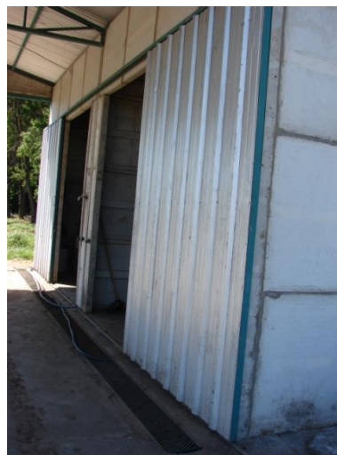
Izq. arriba: Sala de lavado de El Arapey: cocina, depósito y área de carga y descarga. Izq. Abajo: Vista interna de la cocina. Der.: Puertas corredizas de cocina y depósito. Canaletas de desagüe.
