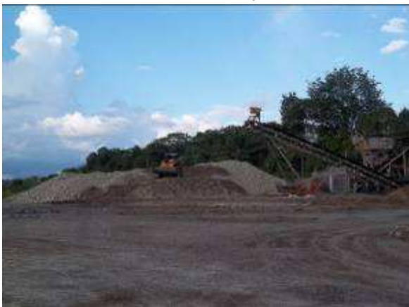
Foto No. 3, Área de acopio de material.
