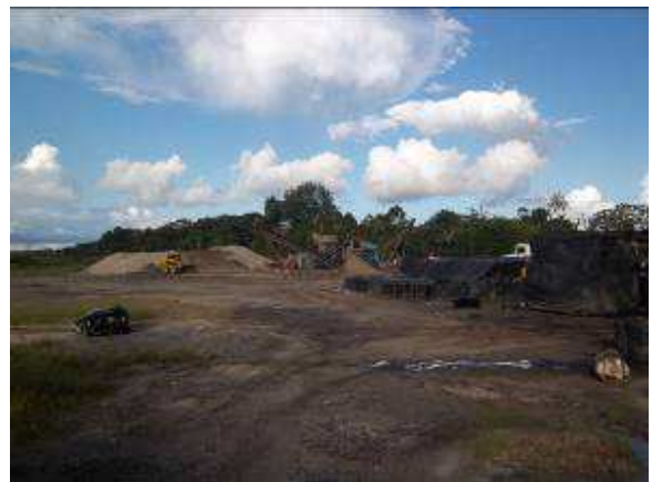
Foto No. 4, Campamento de Obra.
