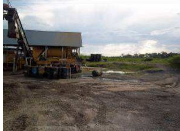
Foto No. 6, Sistema de tratamiento de lodos.
