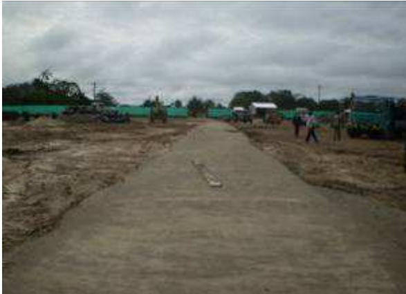
Foto No. 11, Vía interna de acceso.
