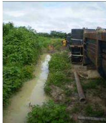
Foto No. 10, Canales perimetrales de aguas lluvias.
