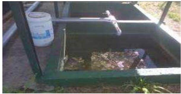
Figura Nro. 4. Lechos de secado de la PTAR
