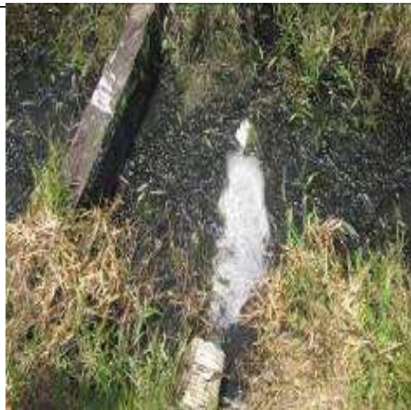
Figura Nro. 6. Punto de vertimientos a canal de agua conformado en tierra de la pista del aeropuerto.
