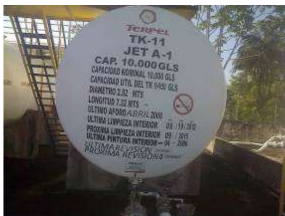
Figura 6. Tanque de almacenamiento de combustible No. 11 capacidad de 10000 galones.
