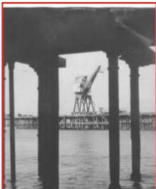
Construcción de Muelles
