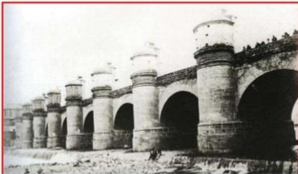
Canalización del Río Mapocho
