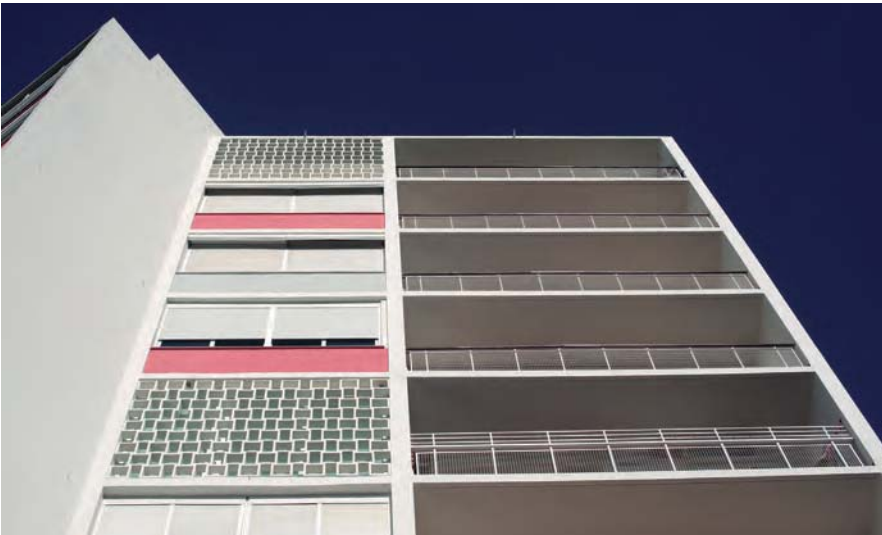
Figura 8. Tower in Nova Oeiras. Imagen: Ibíd. , p. 110.
