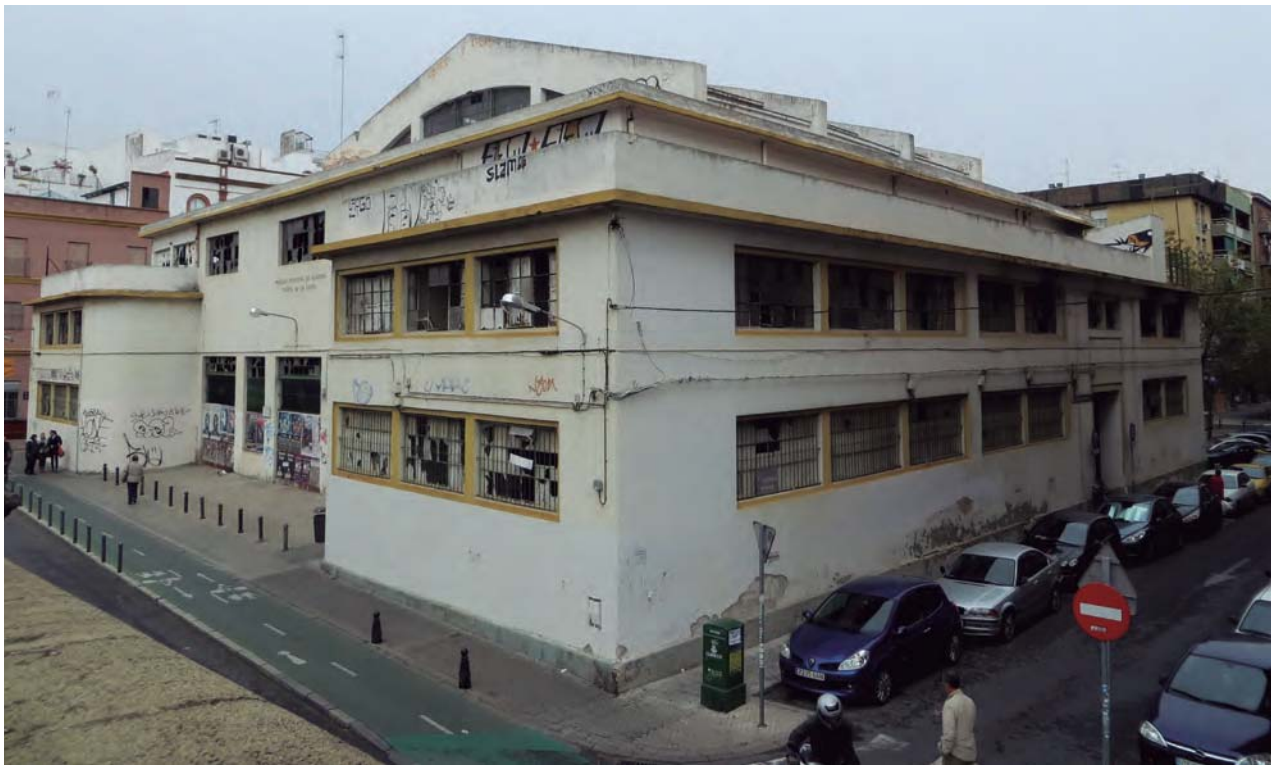
Figura 10. Mercado de la Puerta de la Carne en Sevilla. Imagen: Eduardo Mosquera.
