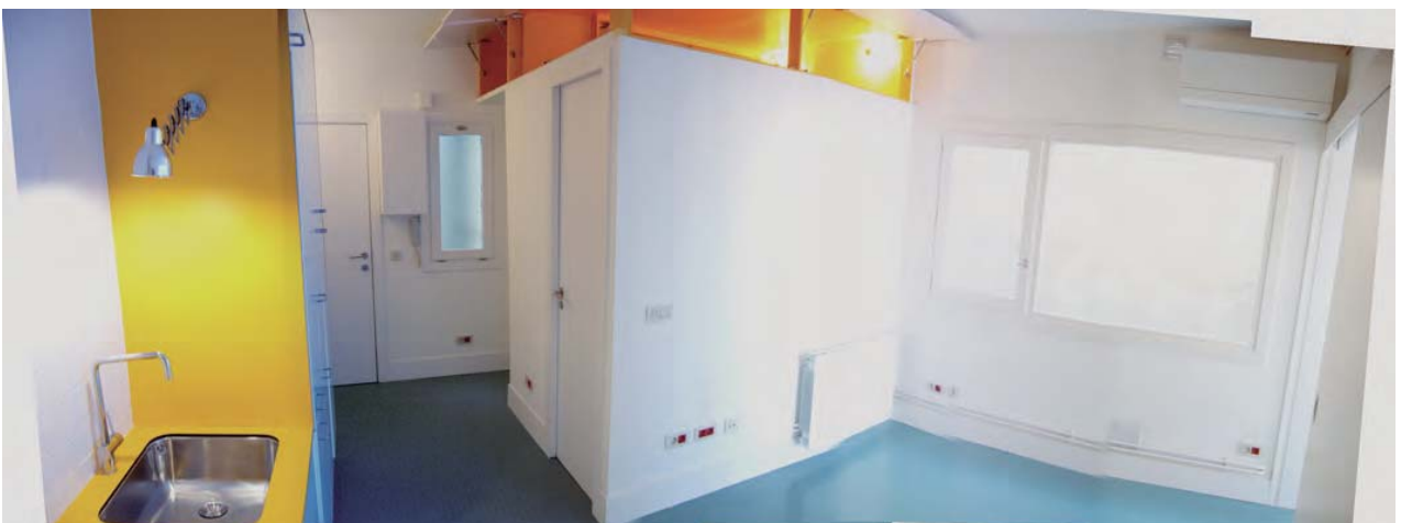
Figuras 3, 4 y 5. Estado de la vivienda de Rosselló 36, Ático 2ª, el 6 de marzo de 2015.
