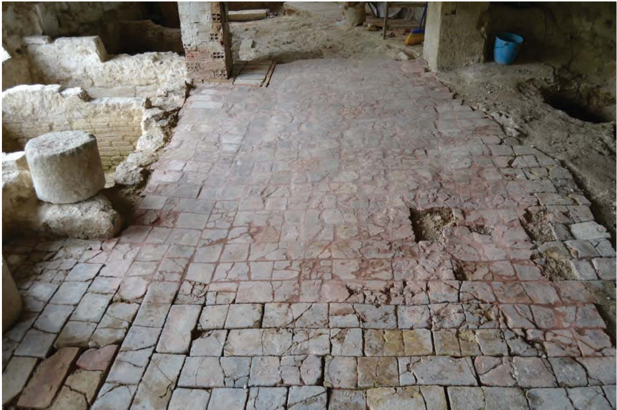
Figura 2. Materiales cerámicos en los pavimentos de la Casa de la Moneda, hoy Albergue de Curtidores. Lo que constituía una solución técnica corriente en 1796 ha devenido singular en nuestros días.
