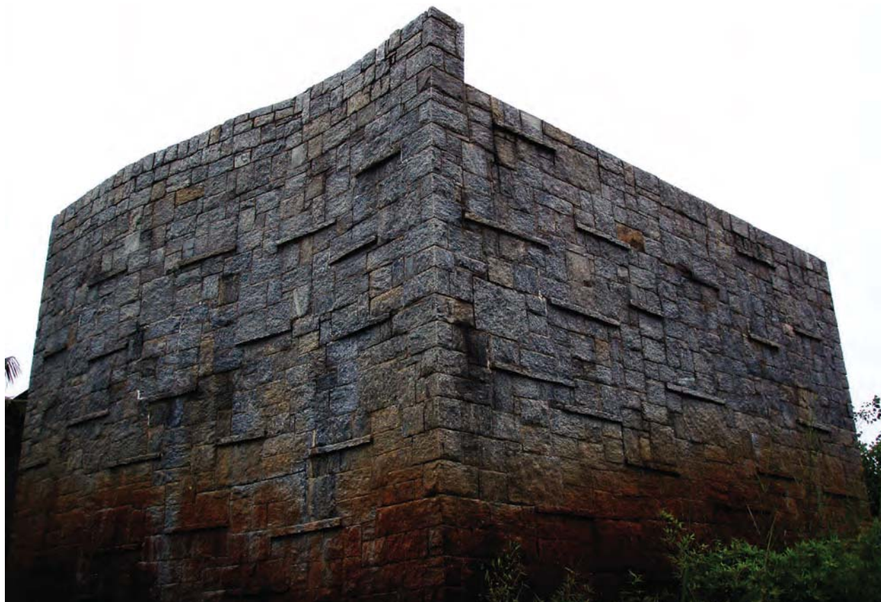
Figura 1. Detalle cerramiento de piedra orientación oeste. Imagen: Juan Moreno.
