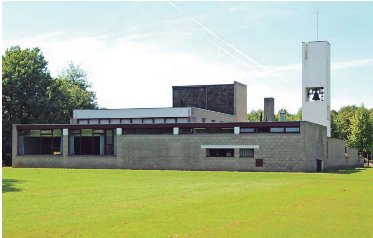
Figura 3. Iglesia reformada de Nagele (1958-1962), Van den Broek y Bakema. Fotografía: Jeroen Roorda.
