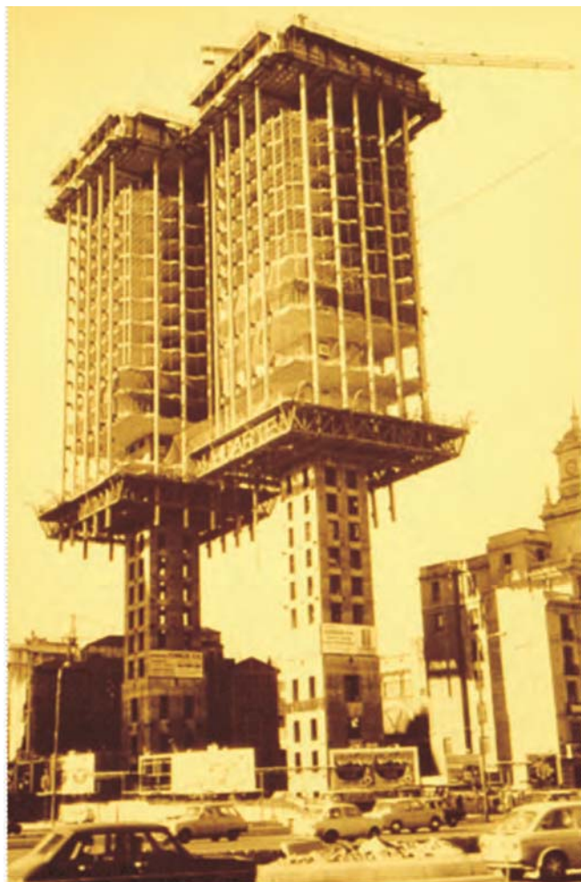
Figura 1. Ejemplo de estructura singular por su sistema de transmisión de cargas: las Torres de Colón (entonces de Jerez) durante su construcción, entre 1967 y 1976 Imagen: cortesía de Máximo de las Casas Pulido, http://madridayer.wordpress.com/ .
