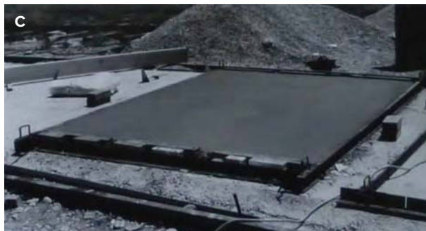
Figura 6. Proceso de fabricación del elemento panel.
