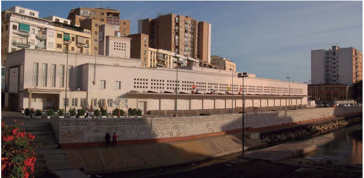
Figura 6. Exterior del Centro de Arte Contemporáneo de Málaga, antiguo mercado de entradores. Imagen: Eduardo Mosquera.
