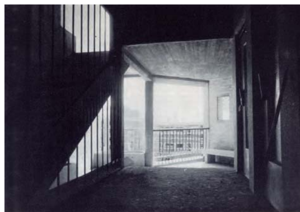
Figura 4. Edifício em Olivais Sul-núcleo central. Fotografia: Revista Hogar y Arquitectura n.º 62, 1966.
