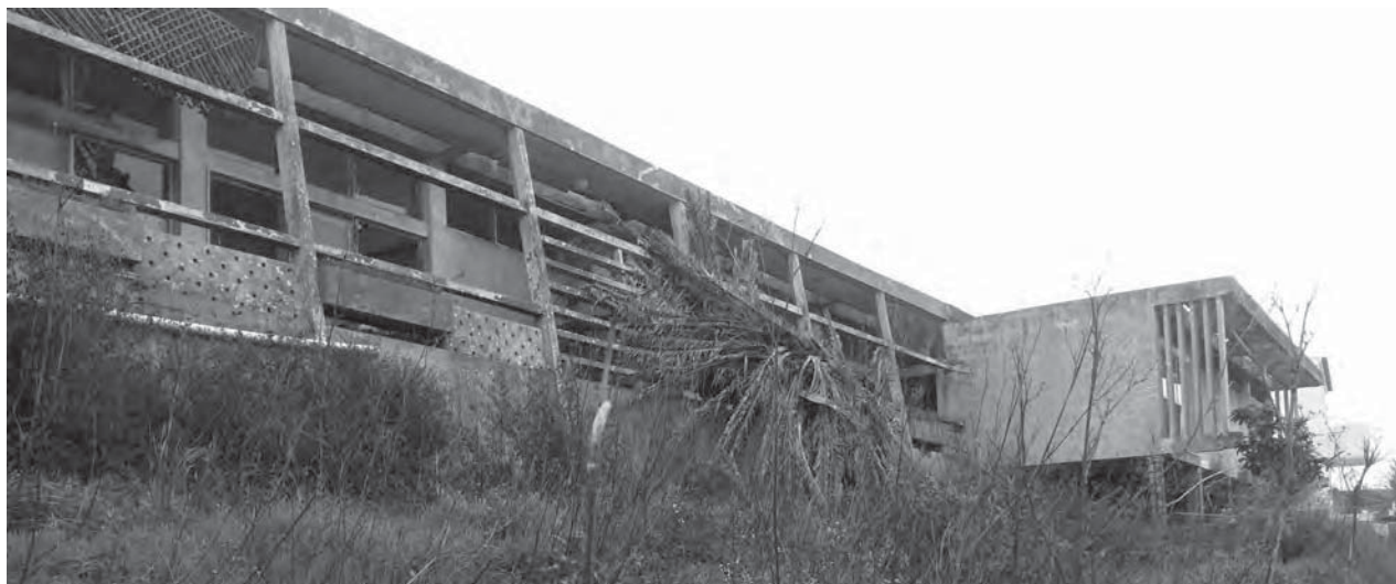
Figura 4. Fachada sur de la Creche de Aljezur, 2014. Fotografía: Miriam Lousame Gutiérrez.
