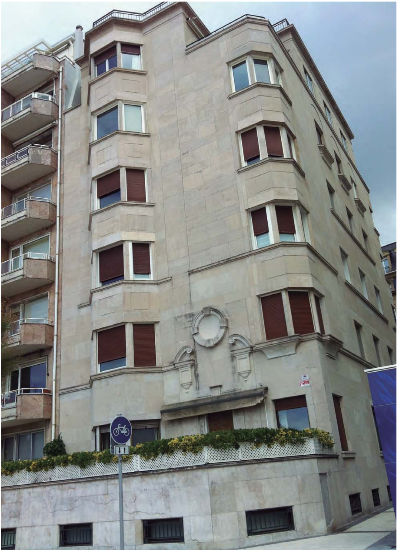
Figura 6. El edificio de la calle Zubieta número 34 en la actualidad
