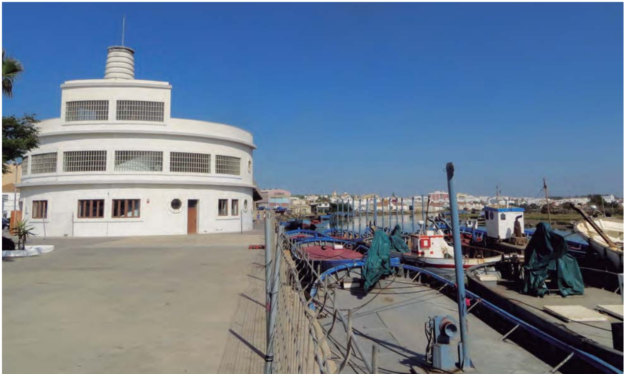
Figura 8. Reconstrucción de la lonja del puerto viejo de Barbate. Imagen: Clara Mosquera.
