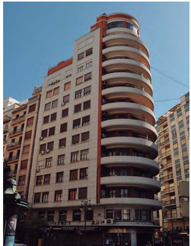
Figura 4. Edificio Merle Morand, calle San Vicente 84, Ignacio de Cárdenas Pastor, 1946.
