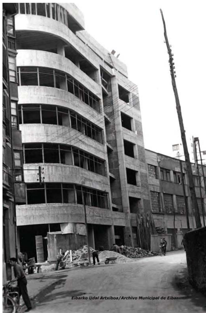
Figura 6. Nuevo edificio de Alfa, Joaquín Domínguez, 1956. Fotografía: Archivo Municipal de Éibar, A EDIF20.
