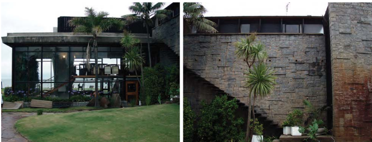
Figura 5. Detalles del espacio de restaurante y del cerramiento sur de la zona servicios de La Solana, Antonio Bonet Castellana. Imagen: Juan Moreno.
