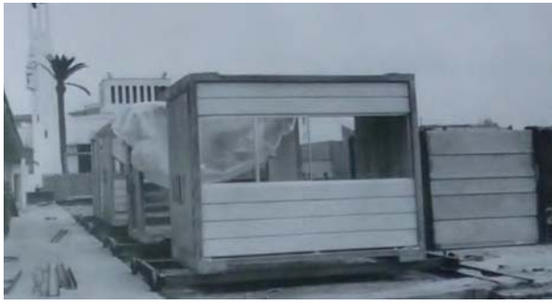
Figura 8. Cadena de montaje de elementos modulares de fachada.
