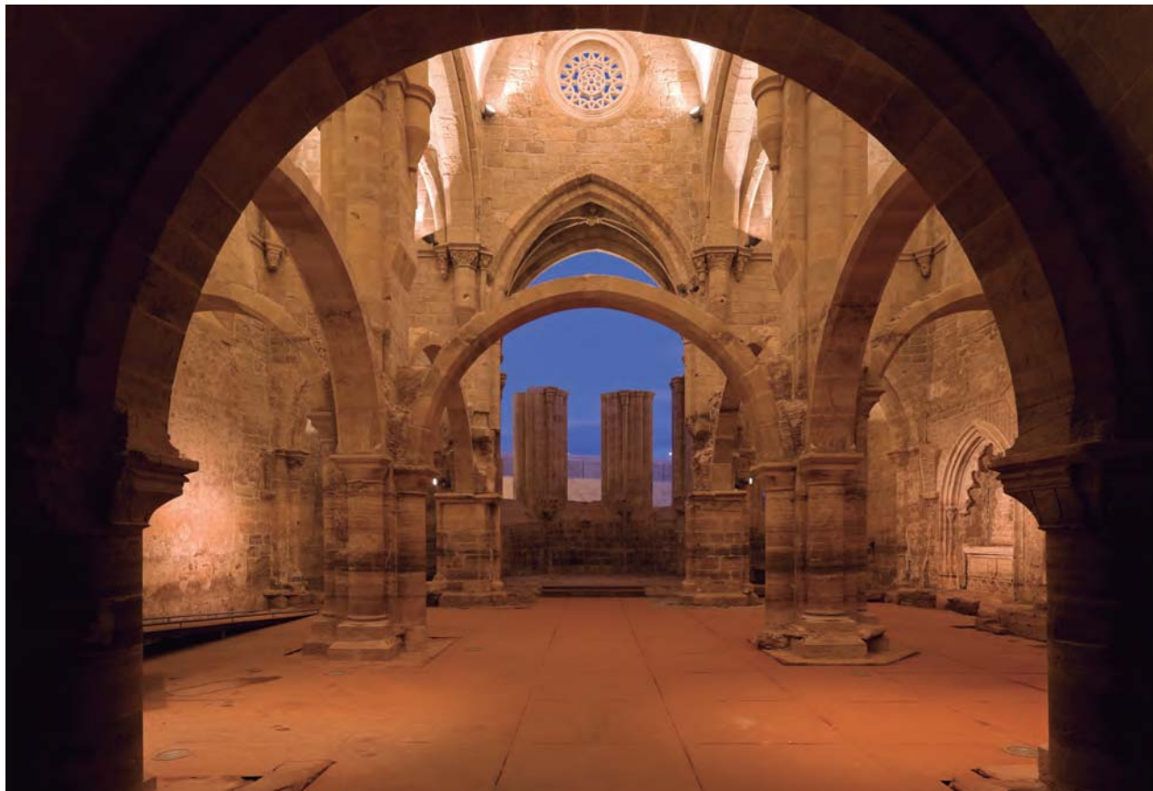
Figura 12. Claustro e da Igreja de Santa Clara-a-Velha. Cabeceira da Igreja após a intervenção. Fotografia: Atelier 15.
