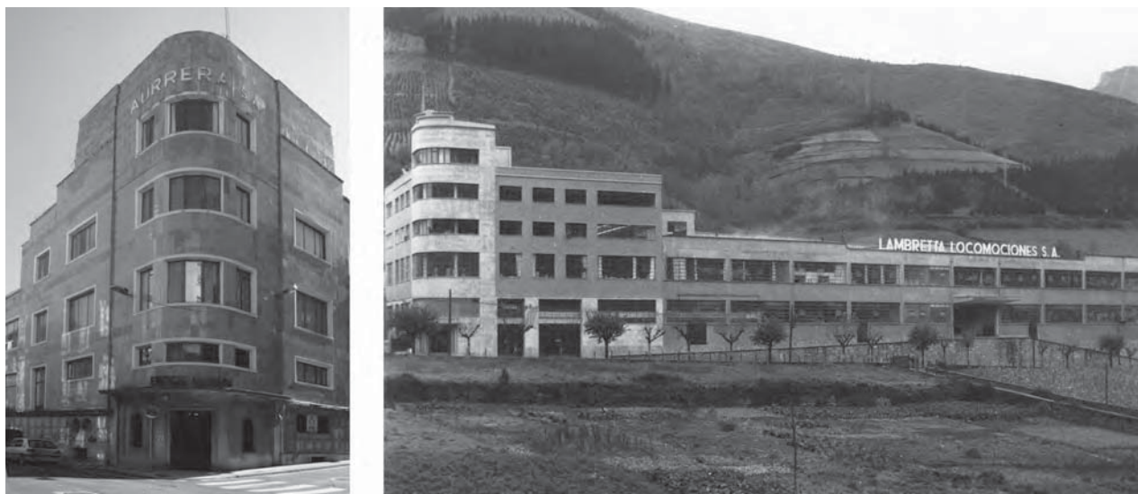
Figura 1. El edificio de la Fundación Aurrera, Raimundo Alberdi, 1942, y el edificio de Lambretta Locomociones S. A., Joaquín Domínguez, 1951. Dos ejemplos de la arquitectura industrial del movimiento moderno de Eibar.
