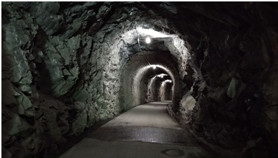
Imagen 32. Acondicionamiento del túnel de Larrakaitz en Sunbilla.
