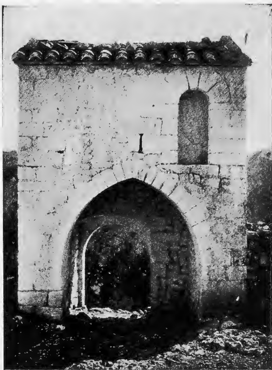
Torreón de la puerta de la parte S.
