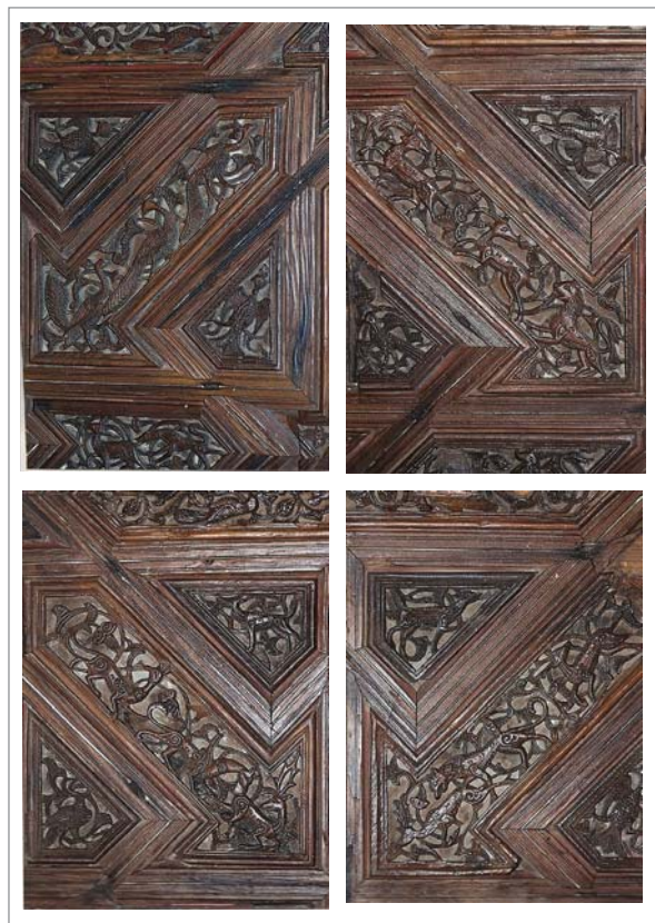
Figura 3. Techo del Palacio Real de Palermo. Detalles.
