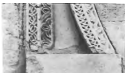
Figura 5. La pieza lisa añadida en restauraciones modernas sobre la que descansan los arranques del trasdós y del alfiz, Puerta de San Esteban de la mezquita aljama de Córdoba.
