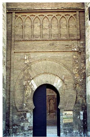
Figuras 153, 154. Arcos concéntricos de rosca de Herradura con línea común de impostas. 1, 2, 4, 5, 6, arco de entrada del ribat de Susa, siglo IX, X, dibujos (1 (2) (según Lézine); 7, arcos de ladrillo apuntados de puerta de la Gran Mezquita de Qayrawan, siglo XIII; 8 arco califal del castillo de Maqueda (Toledo), aquí sobresaliente el arco exterior, como el arco (A) de la entrada de la Aljafería.
