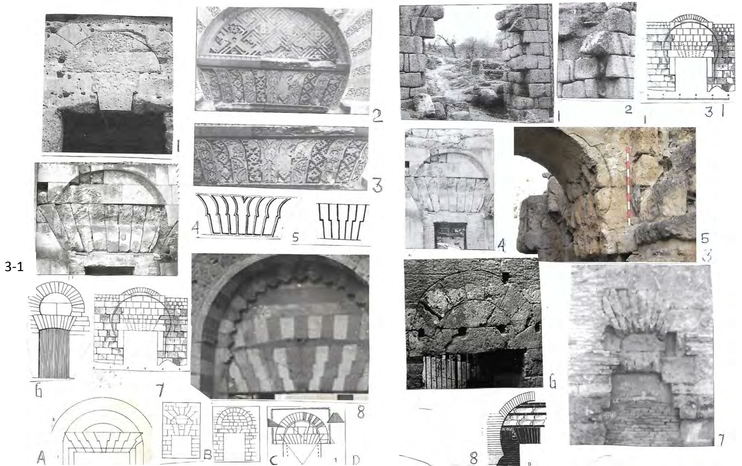
Figuras 34, 35, 36. 1 del teatro romano de Orange, en el dintel dovelas engatilladas; 2, 3, 4, una de las puertas de la fachada occidental de la mezquita aljama de Córdoba del siglo X, dintel con dovelas engatilladas, los modelos aparte de la puerta (1), arco de Lepcis Magna (A), arco romano de Tarragona (B), una puerta de qasr omeya de Siria (C); 8, dovelas engatilladas de la Puerta fatimí Bab al-Futuh de El Cairo; 3-1, una de las puertas de la mezquita de Santa Clara de Córdoba, siglo X, en este caso dintel de piedra con arco rebajado o inciso, modelo de una de las puertas de la ciudad-fortaleza de Vascos (Toledo), siglo X (7); 6 del alminar de la Gran Mezquita de Qayrawan, siglo IX-X; D, puerta de los Deanes, fachada interior de la mezquita aljama de Córdoba, siglo IX.
