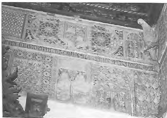
Figura 192. Yesería alta de la capilla de Santa María de Arbás, Mayorga de Campos (Valladolid).
