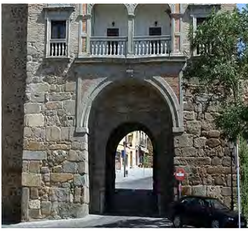
Figura 20-1. Exterior de la Puerta del Cambrón con los sillares o sillarejos de las dos torres hasta por encima del arco moderno. B, revocados los aparejos en época incierta; A, fachada limpia de los revocos anteriores, según estaba en la Edad Media, así lo vio Gómez-Moreno y Torres Balbás.
