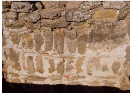
Figura 27-1. 1. Hiladas atizonadas de toscas rocas, del interior de la puerta de Alcántara, fábrica muy generalizada de la Marca Media provinciana; 2, de obra islámica de Recópolis 63 .
