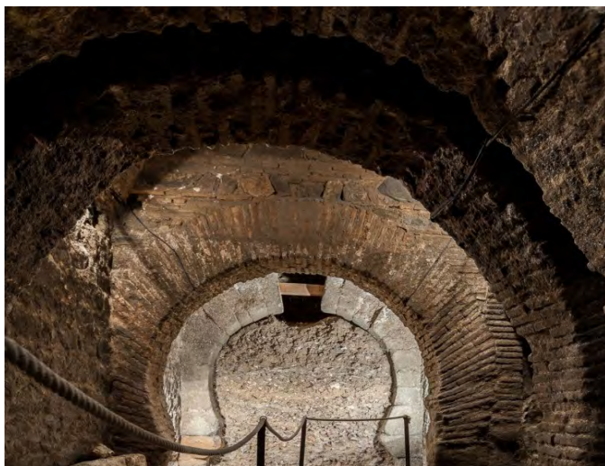
Figura 29-1. Puerta del Vado, del último término al primero, arco de herradura de piedra, arco de herradura de ladrillo de dovelaje completo y los dos arcos de medio punto de ladrillo del rastrillo, estos tres últimos como en Bisagra Vieja
