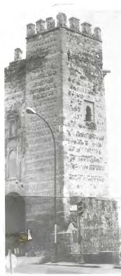
Figura 28, Puerta interior del Puente Alcántara de Toledo, obra mudéjar del siglo XIII-XIV. Planta dentro ya de la ciudad, tramo de cuatro mochetas árabes clásicas, rastrillo y tramo con puentecilla de la escalera de subida al segundo piso. La torre de mampostería encintada con asiento de sillares, por dentro el segundo tramo enseña bóveda de crucería gótica al estilo de la entrada de la Puerta del Sol, ambas bóvedas casi gemelas.
