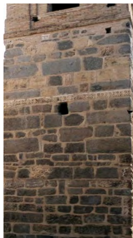
Figura 24. Bab al-Yaud o Puerta de Cambrón. Gómez-Moreno la ve islámica con dos torreones al exterior y corraliza al interior (1), pero le extraña que los arcos sean de medio punto en lugar de herradura, como en Valmardum y Puerta de Alarcón; 3, 4, aparejo de sillares aprovechados de las torres, la imagen (4) ofrece las dos torres con aparejo de sillares muy por encima del arco de medio punto moderno; 3, arco de medio punto interior de estilo romano sin jarjas. El aparejo de sillares de anárquica trabazón se va con el aparejo de la torre –alminar de la mezquita de El Salvador de Toledo- (5); 6, interior actual y exterior del alminar. La torre ofrece interiormente falsas bovedillas de ladrillo mudéjares añadidas hacia en el siglo XIV o XV, al exterior ventanucos o tragaluces semejantes a los del alminar califal de ermita de Santiago en el camino de Medina Sidonia (Cádiz), según Gurriarán y otros (AyTM, 9).
