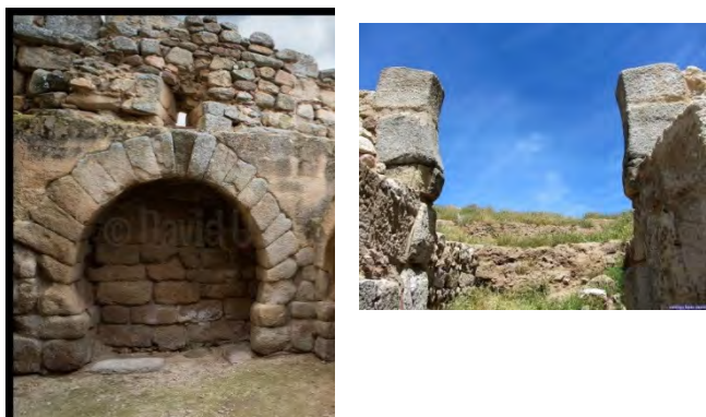
Figura 25. Arco visigodo de Santa María de Melque, herradura, dovelaje completo sin jarjas y trasdós regularmente tratado, son las características del arco de herradura de piedra de la puerta de Alcalá (2).
