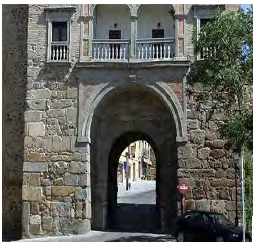
Figura 24. Bab al-Yaud o Puerta de Cambrón. Gómez-Moreno la ve islámica con dos torreones al exterior y corraliza al interior (1), pero le extraña que los arcos sean de medio punto en lugar de herradura, como en Valmardum y Puerta de Alarcón; 3, 4, aparejo de sillares aprovechados de las torres, la imagen (4) ofrece las dos torres con aparejo de sillares muy por encima del arco de medio punto moderno; 3, arco de medio punto interior de estilo romano sin jarjas. El aparejo de sillares de anárquica trabazón se va con el aparejo de la torre –alminar de la mezquita de El Salvador de Toledo- (5); 6, interior actual y exterior del alminar. La torre ofrece interiormente falsas bovedillas de ladrillo mudéjares añadidas hacia en el siglo XIV o XV, al exterior ventanucos o tragaluces semejantes a los del alminar califal de ermita de Santiago en el camino de Medina Sidonia (Cádiz), según Gurriarán y otros (AyTM, 9).
