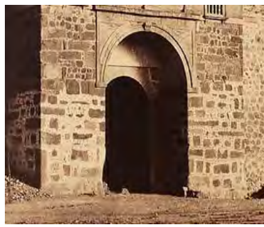
Figura 20-1. Exterior de la Puerta del Cambrón con los sillares o sillarejos de las dos torres hasta por encima del arco moderno. B, revocados los aparejos en época incierta; A, fachada limpia de los revocos anteriores, según estaba en la Edad Media, así lo vio Gómez-Moreno y Torres Balbás.
