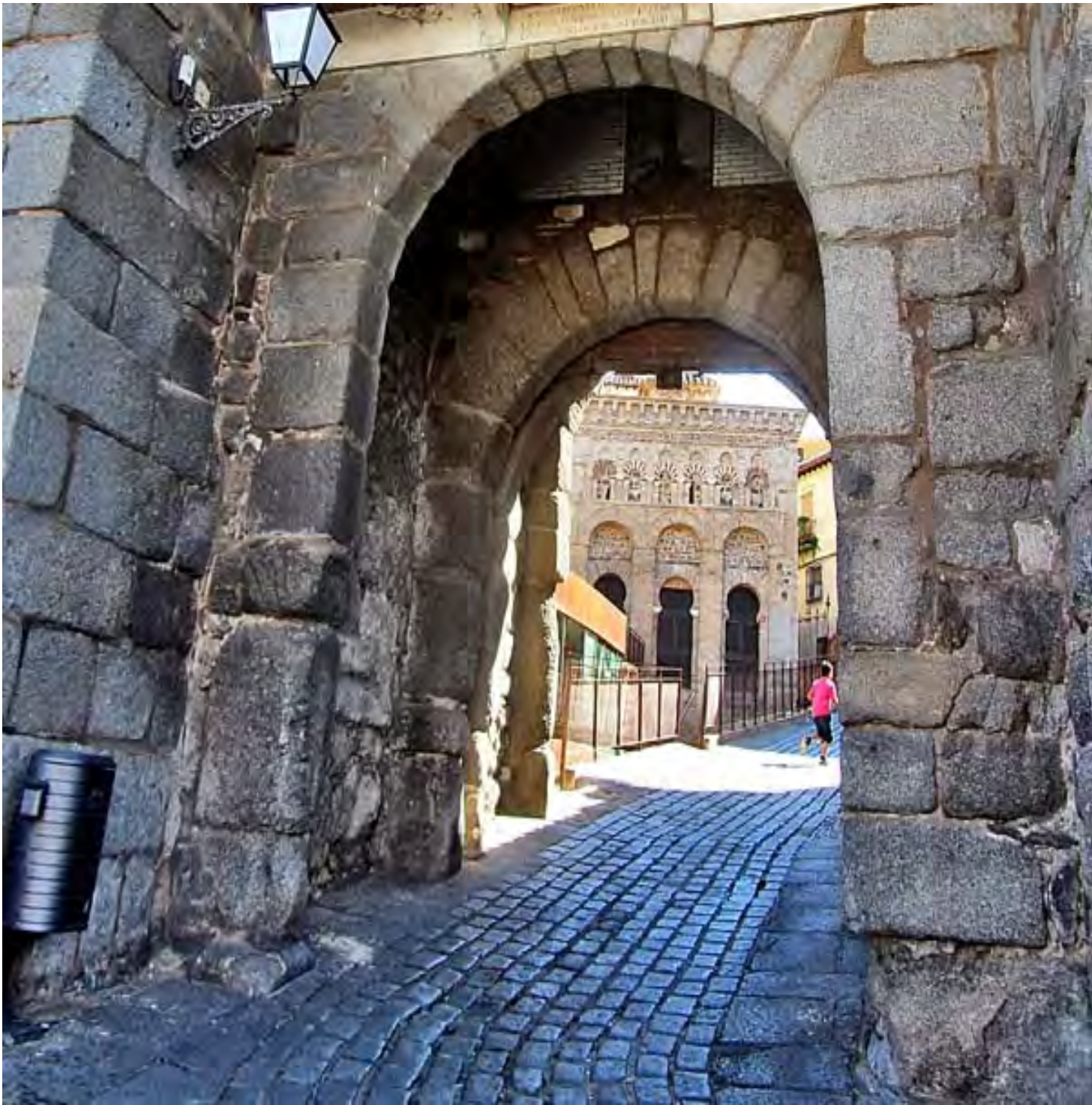
Figura 6. Valmardum vista de afuera a dentro. El arco exterior medio punto enjarjado con sendas cuñas no muy iguales, trece dovelas radiales y dos jarjas por lado como el arco de la fachada interior, arcos íntegramente islámicos. Los arcos del rastrillo son también de medio punto pero sin jarjas, como en la Puerta de Cambrón y Puerta de Alarcones. La dovela clave formando una cuña muy pronunciada. En la figura de abajo la puerta al ras del suelo, imagen junto con esta que permite ver que toda la obra, incluidos los arcos del rastrillo, son de una misma jornada constructiva islámica, los arcos todos sin trasdós formalizado. En esta ocasión la argamasa de llagas es muy terrosa con cantillos incrustados. Valmardum es el nombre de esta puerta registrado en los documentos mozárabes de los siglos XII y XIII , aunque se manejan otros nombres, el árabe es Bab al-Mardum con el significado de puerta oculta, tapada, tabicada o cerrada. A juzgar por los arcos de medio punto algunos autores, entre ellos yo mismo, hemos querido ver en ella arcaísmos muy marcados hasta el punto de hacerla llevar hasta el siglo VIII e incluso a época de la Antigüedad Tardía. ¿Cuándo o desde cuándo esta puerta estaba o estuvo cerrada? Si con los árabes estaba inutilizada la comunicación de la ciudad alta con el arrabal no podía ser otra que
