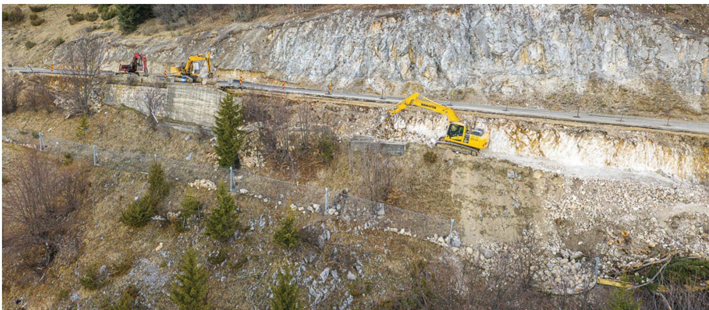
Figura 4 - Bariera GBE 100A-R și versant stabilizat cu Sistem TECCO® G65/3
