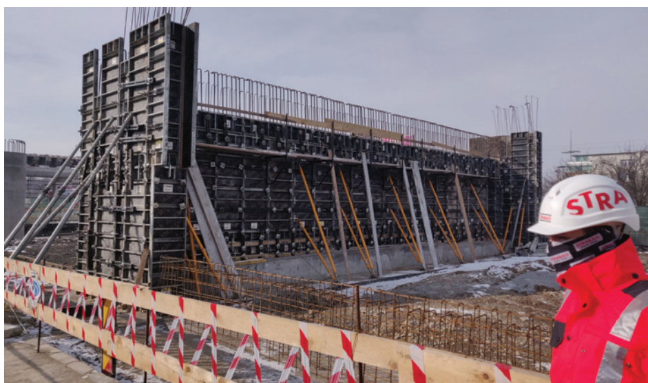
Fig. 2 - Aspecte ale lucrărilor pasajului de la Mogoșoaia
