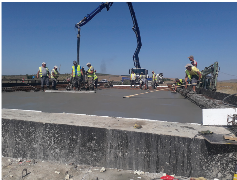
Fig. 5 - Aspecte de la lucrările noului pod
