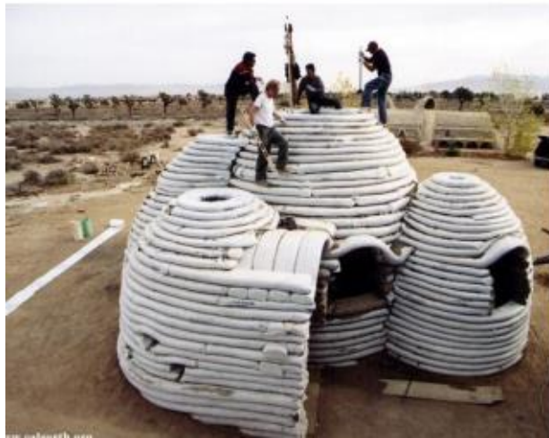
Figura: Técnica de superadobe Fuente: Fabio Gatti
