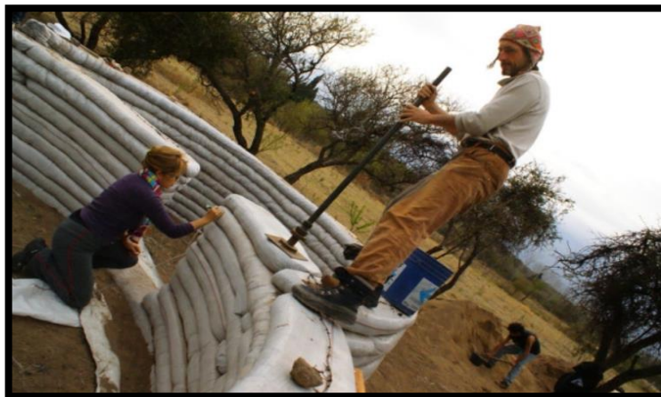
Figura: Técnica de superadobe Fuente: Fabio Gatti
