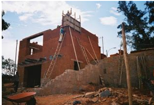
Figura 9. Construcción en tapia pisada Fuente. http://tapiapisada.blogspot.com.co
