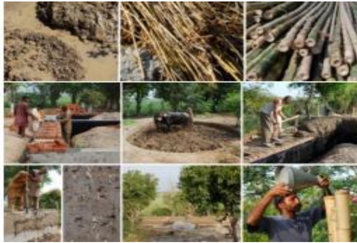
Figura: Proceso de técnica Cob Fuente: Fabio Gatti
