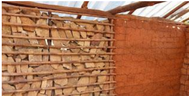
Figura 10. Construcción en Bahareque Barichara Colombia Fuente. http://baricharamonumento.blogspot.com.co
