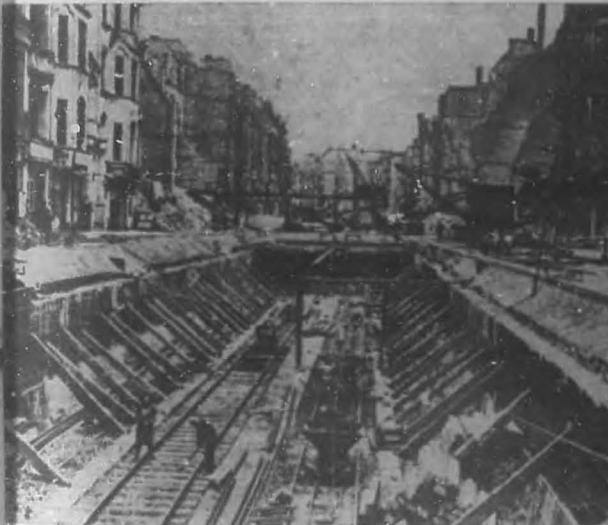
Mujeres alemanas trabajando en la reconstrucción del "subway" berlinés. Gran parte de éste fue volado por las tropas S.S. para detener el avance de los rusos durante la pelea en el interior de la ciudad.
