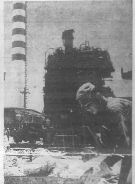
Un aspecto de la termoeléctrica IGNACIO AGRAMONTE. Tiene dos turbogeneradores de 60 mil kilowatts cada uno y está preparada para instalarle en el futuro dos más de igual capacidad. Su costo sobrepasa de 32 millones de pesos.
