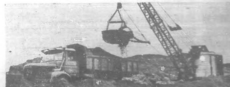
Hasta 1967 han entrado 5,436 camiones de volteo y 23,936 camiones de plataforma, así como 873 excavadoras y grúas.
