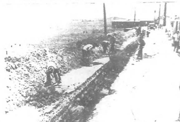
Excavaciones de zanjas para instalar la nueva red del alcantarillado.
