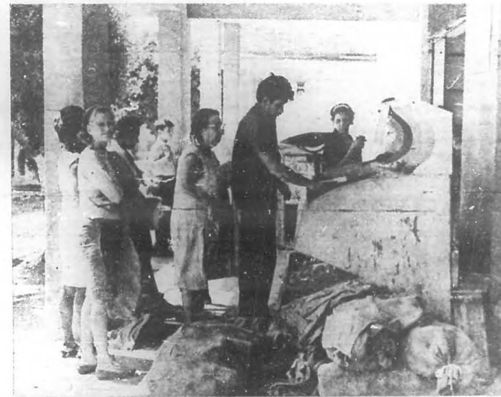
Todo funciona normalmente en este puesto intervenido. Los abastecimientos llegan aún más rápido a la población.
