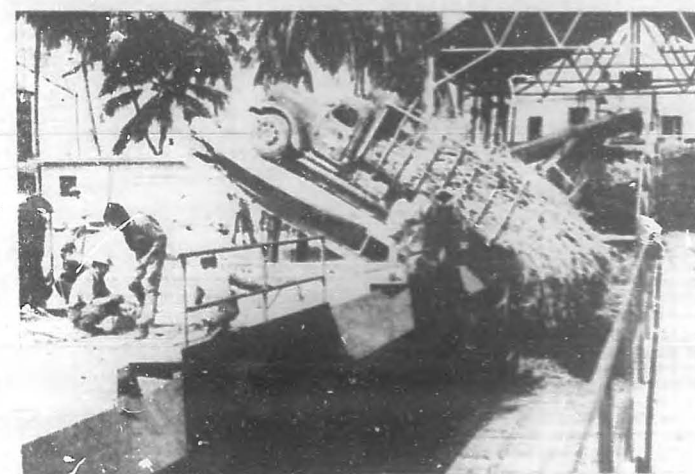
En el central "Urbano Noris", de San Germán, Oriente, donde se efectúan grandes inversiones en ampliación y modernización del ingenio, de acuerdo con el Plan Perspectivo, que convertirán al mismo en uno de los dos mayores de Cuba en 1970, se ha instalado un virador hidráulico para camiones y otros dos se encuentran en construcción. El nuevo equipo logra un buen ahorro en el empleo de carros-jaula de ferrocarril en el tiro de caña.
