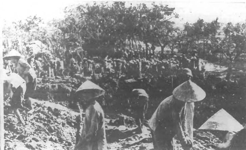
Pero la población de la RDV trabaja heroicamente noche y día, bajo las bombas y las balas del agresor extranjero. La población ayuda a restaurar la represa de Fu Sa, destruida por la aviación enemiga.
