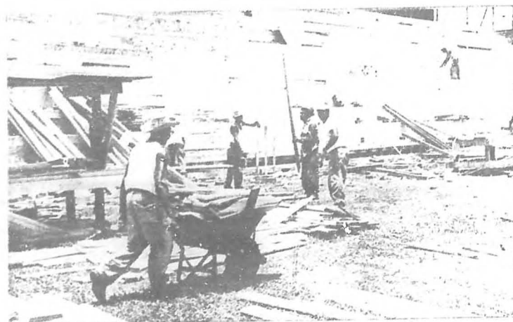
La gradería donde va la Pizarra Humana en el Estadio Latinoamericano tiene 92 metros de largo por 9.75 de ancho y una altura de 7.20 metros, y las tres pantallas que funcionarán con las composiciones filmen una altura de 20.50 metros, cada una, y 16.50 de ancho.
